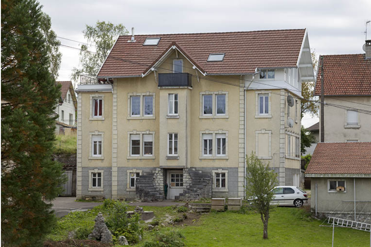
Maison : façade postérieure.
