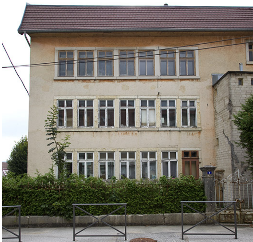
Usine : façade postérieure.
