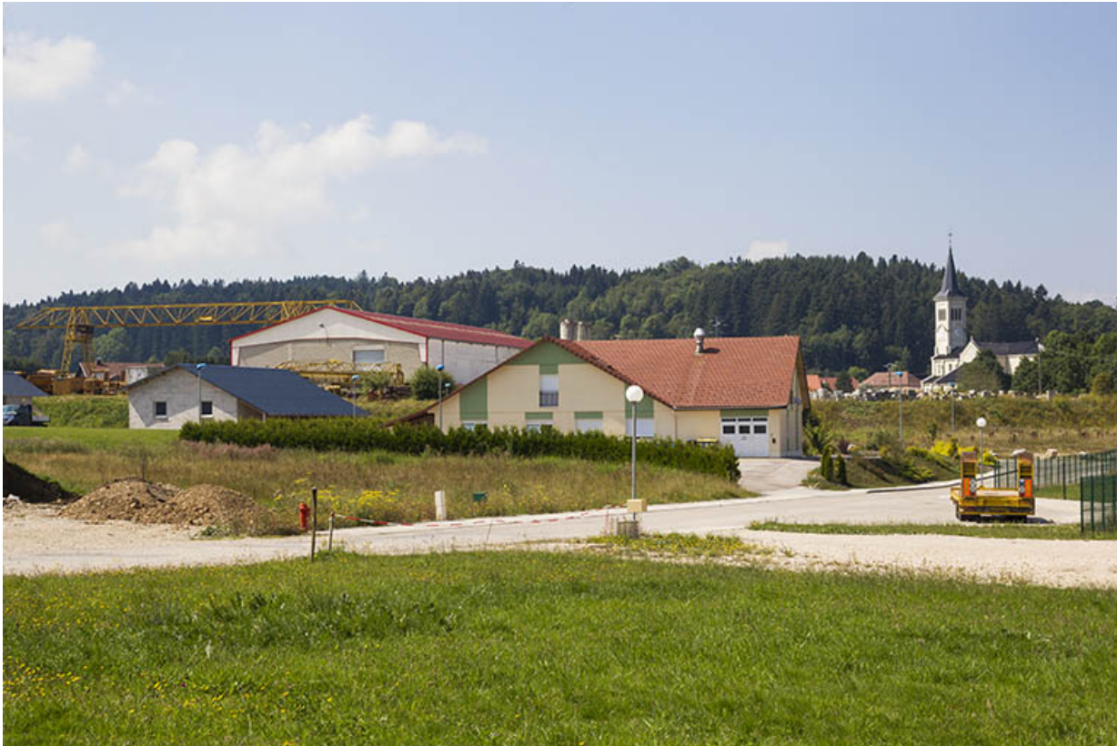
Vue d'ensemble, depuis l'est (façade postérieure).
