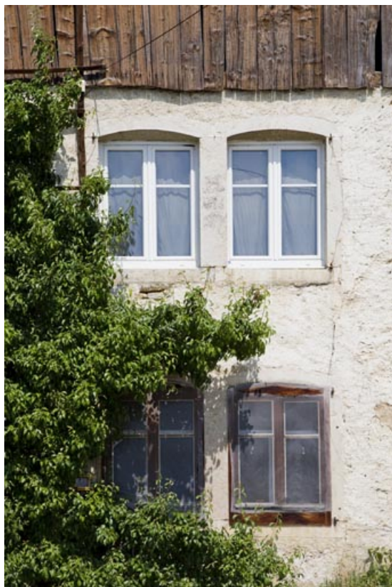
Travée de fenêtres doubles en façade.
