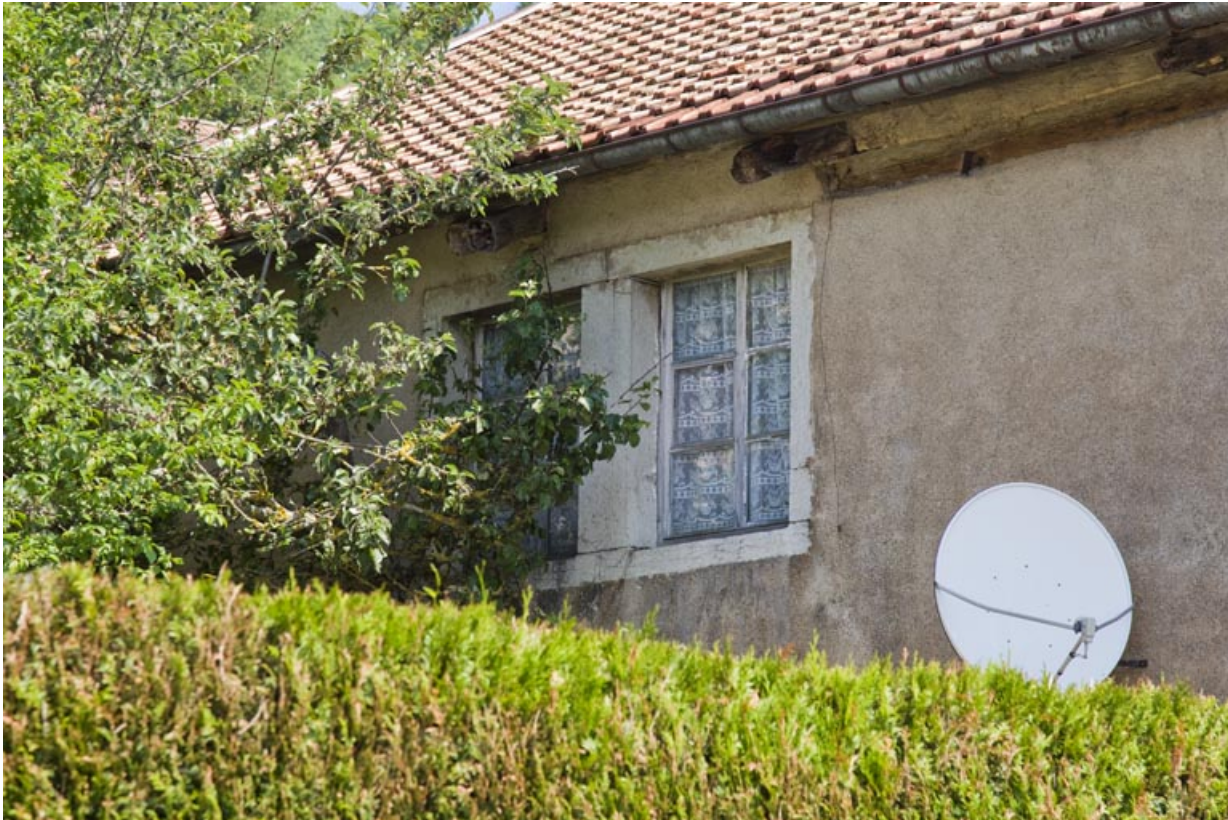
Fenêtre double sur la façade latérale gauche.
