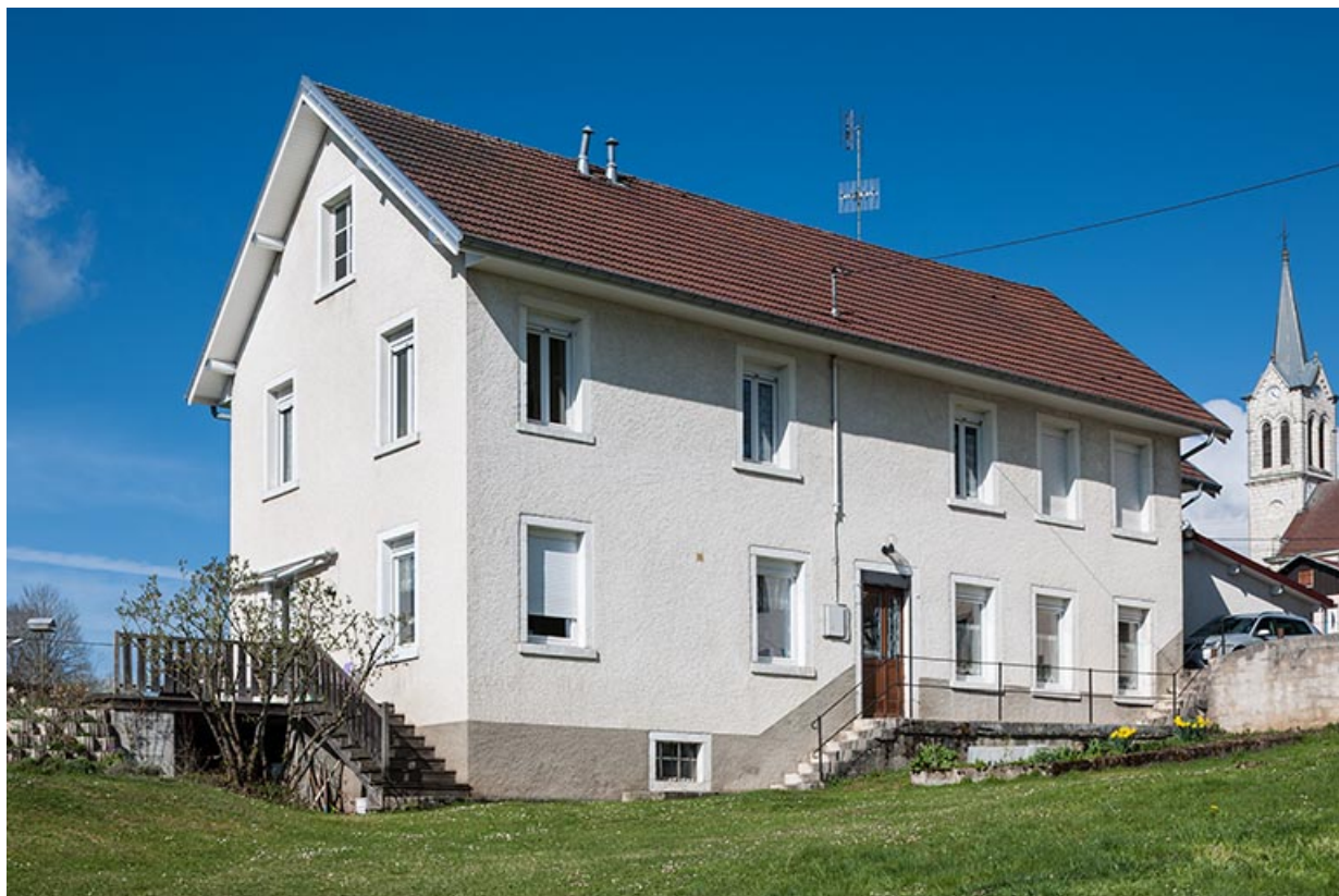
Atelier : façade antérieure, de trois quarts gauche.
