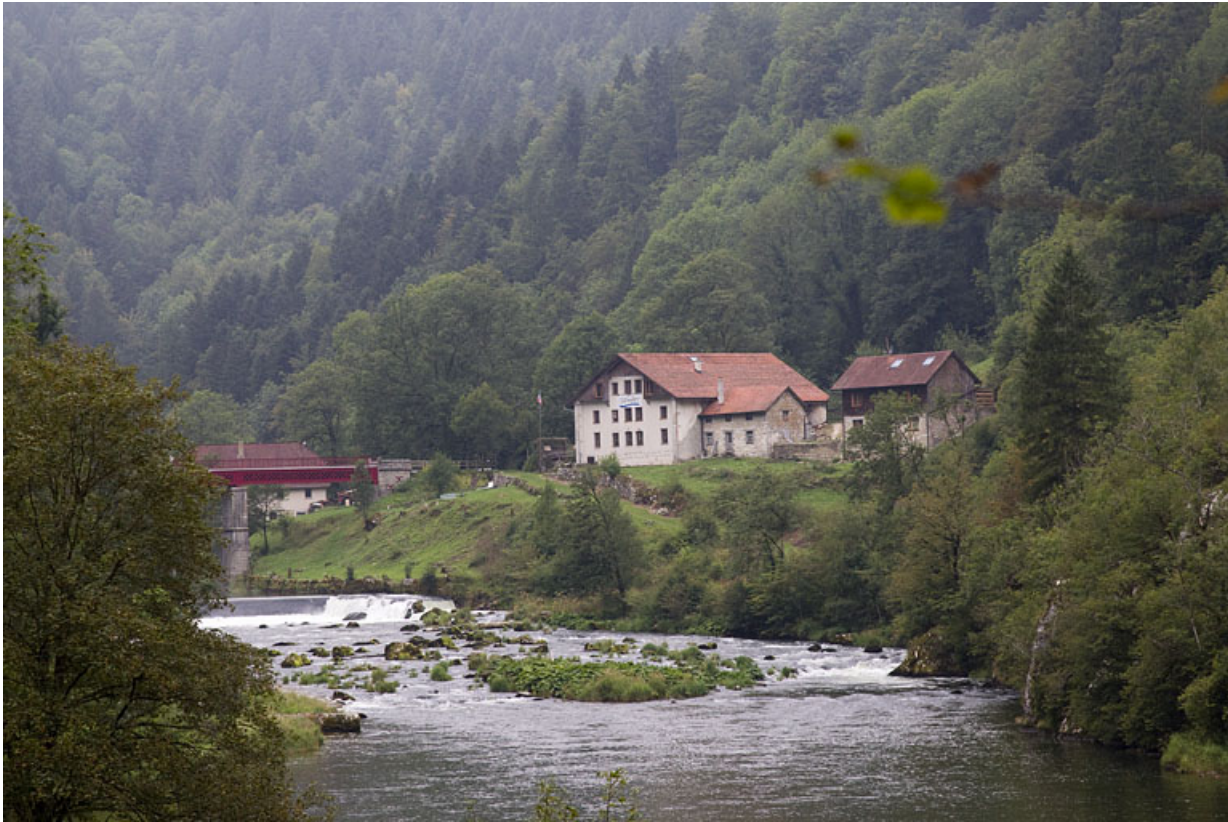
Vue d'ensemble du site depuis l'aval.
