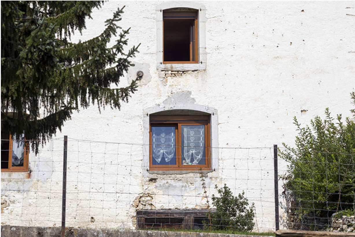
Façade est : fenêtres.
