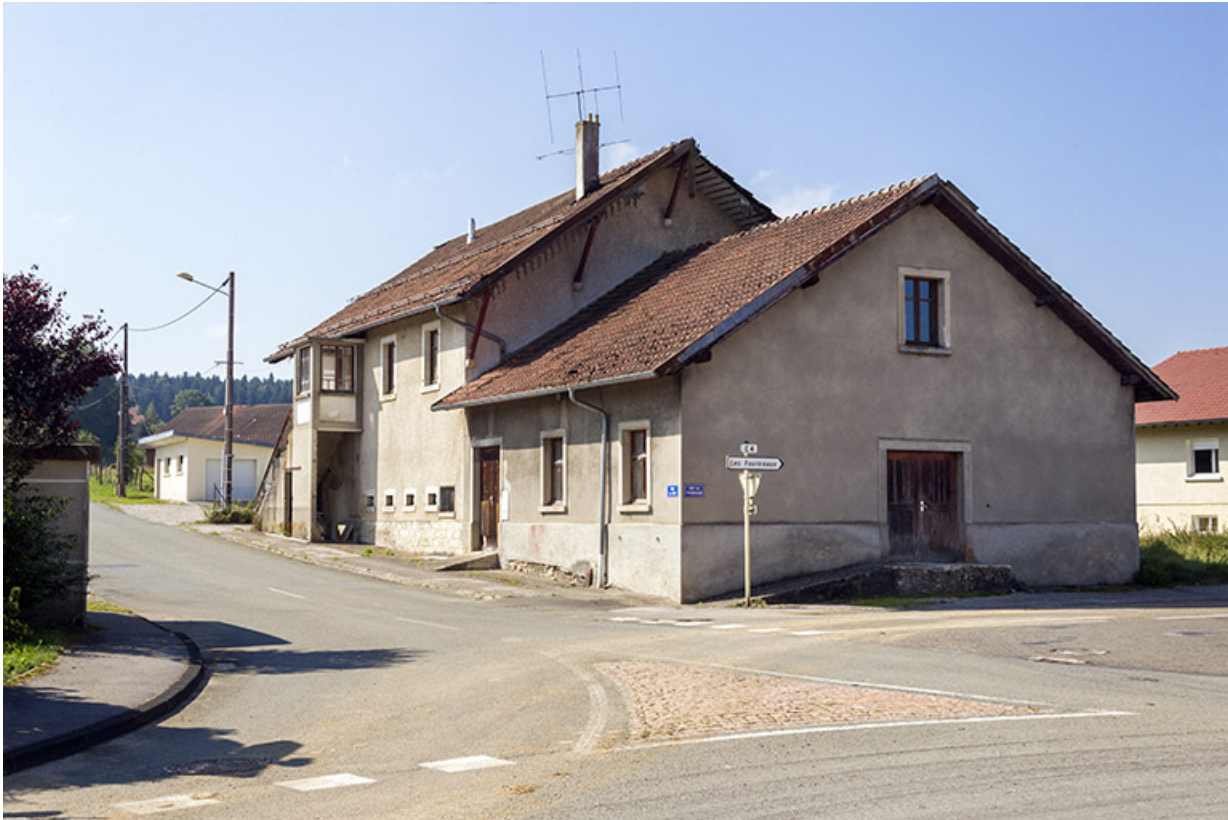
Façades postérieure et latérale droite.
