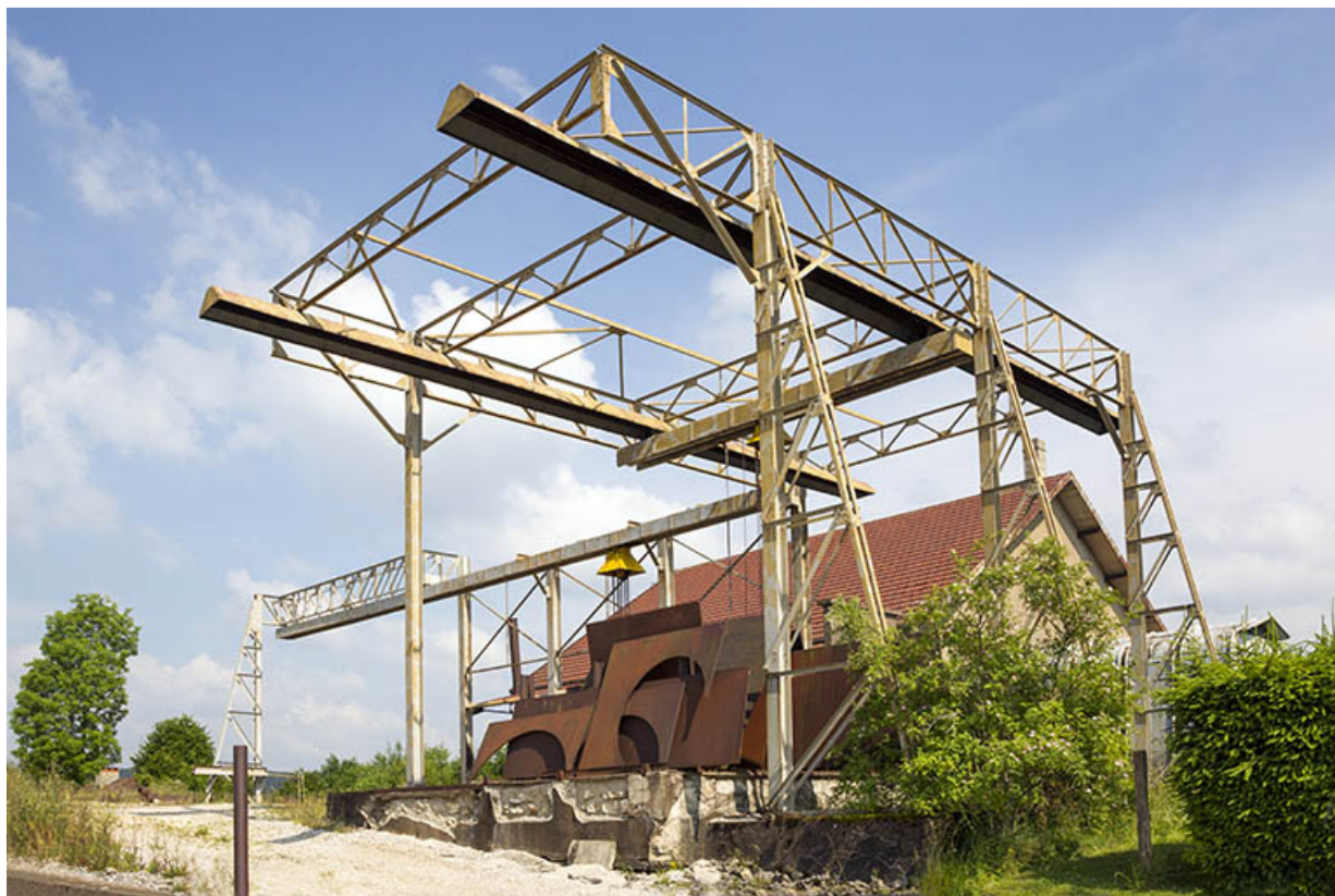
Site rue du Contremont : portique de manutention.
