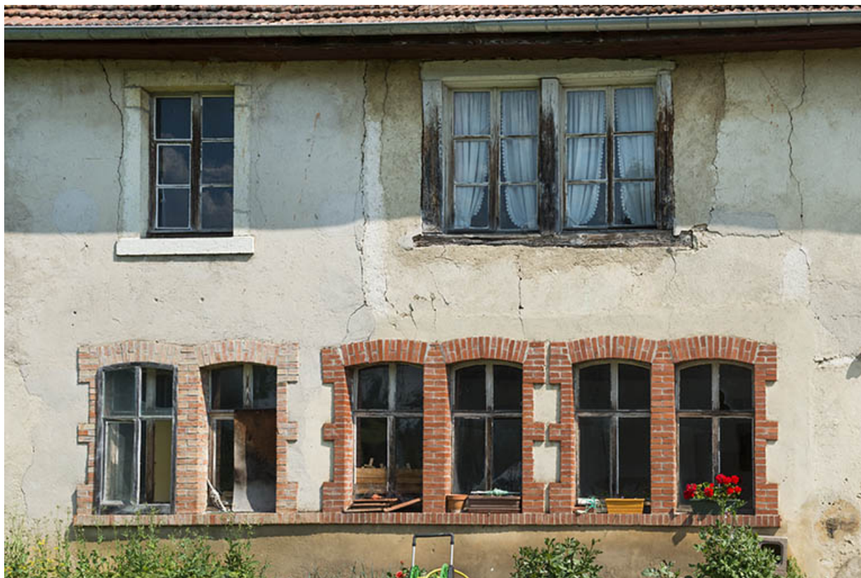
Fenêtres horlogères sur la façade antérieure.
