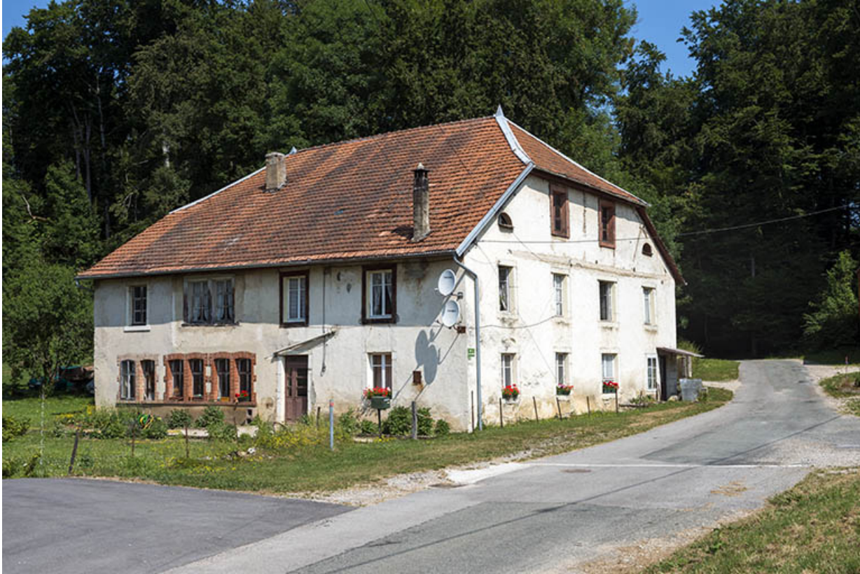
Façades antérieure et latérale droite.
