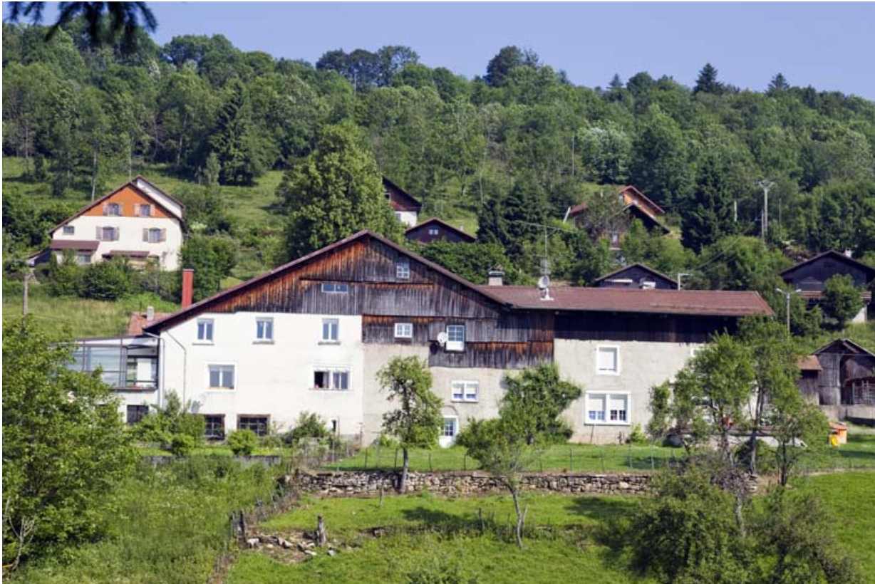
Façade latérale droite.
