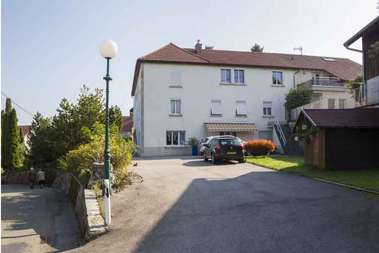
Façade latérale droite.
