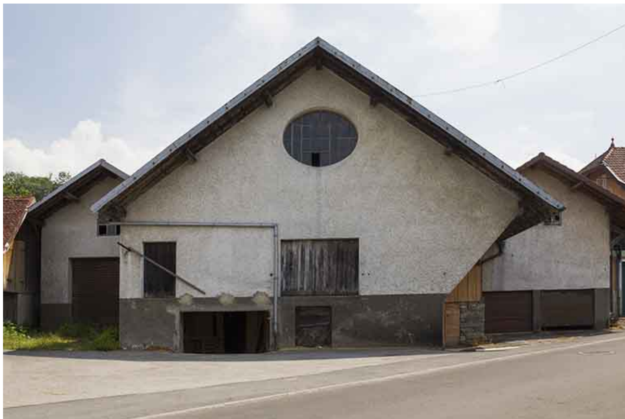
Atelier de fabrication et stockage de sicure.
