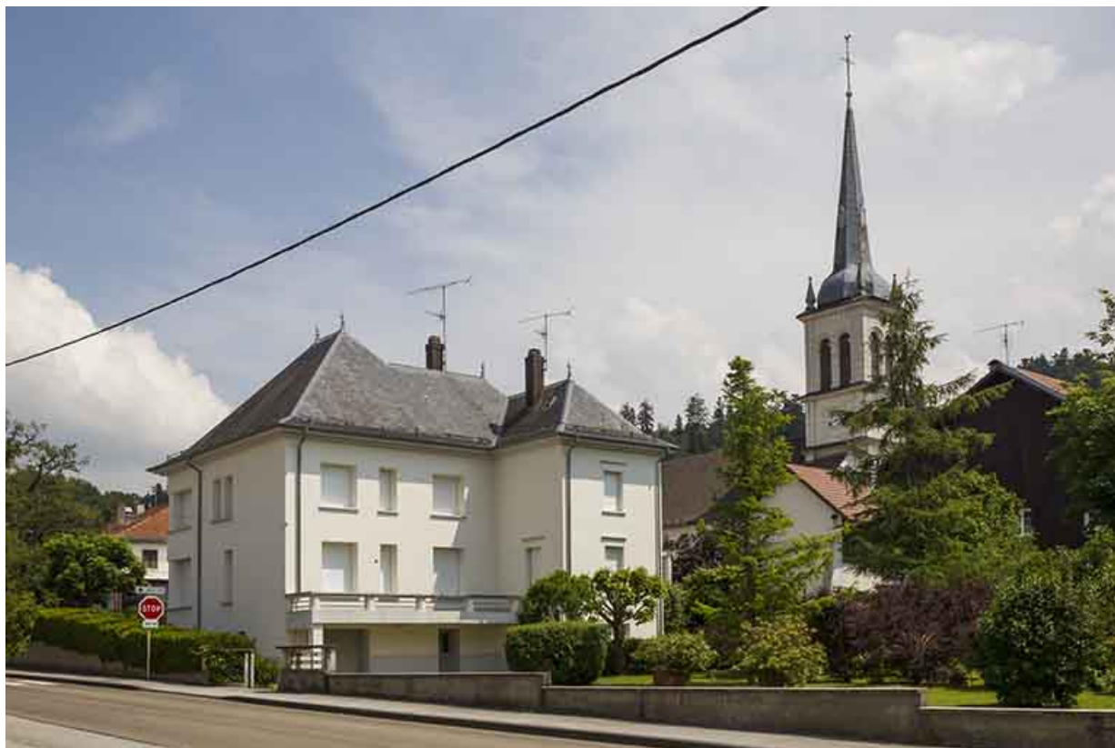
Logement patronal depuis l'ouest (façade postérieure).
