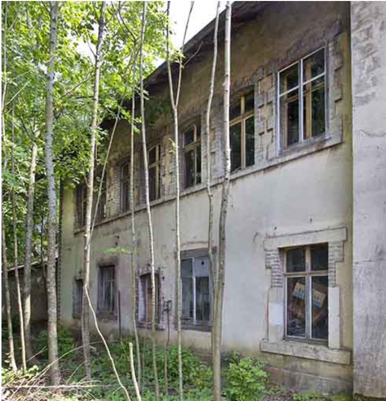
Atelier de fabrication occidental : façade postérieure.
