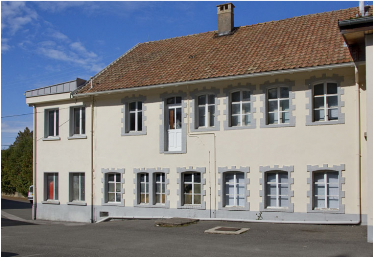
Atelier rehaussé en 1923-1924 : façade latérale droite.
