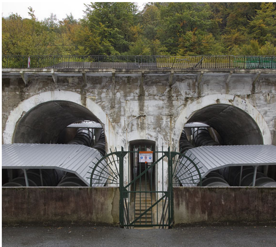
Conduites forcées sous le pont de la route départementale.
