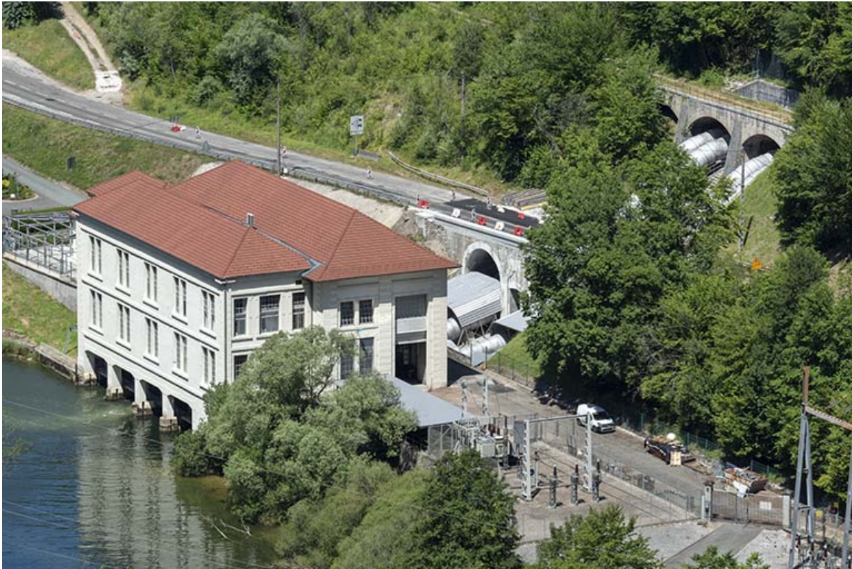
Vue d'ensemble plongeante resserrée, depuis le sud-est.
