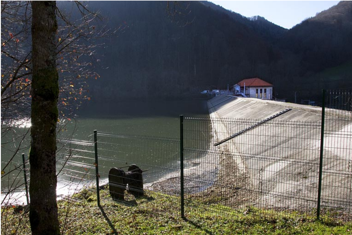
La digue depuis la rive droite.
