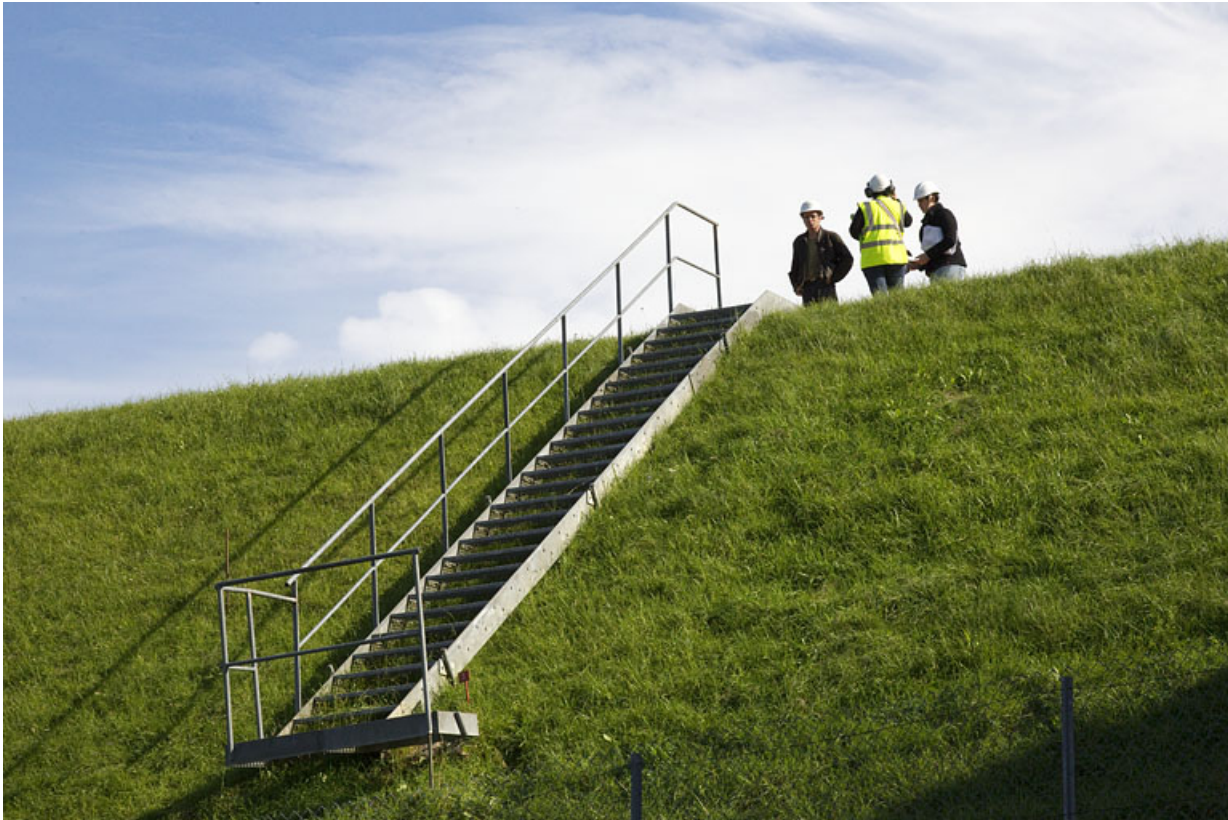
Digue : escalier menant à un puits piézométrique.
