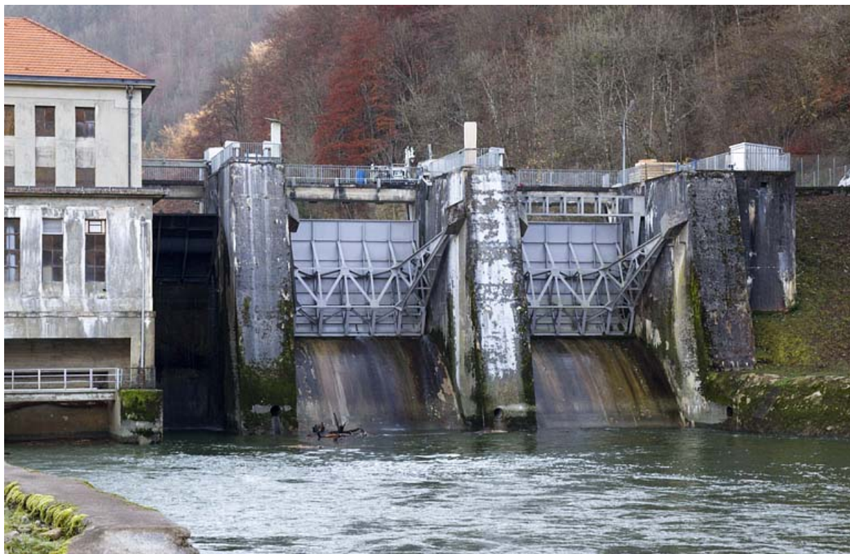
Le barrage vu de l'aval.
