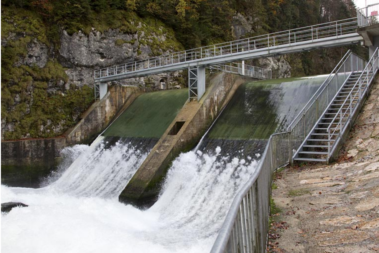
Barrage vu de trois quarts, depuis l'aval.
