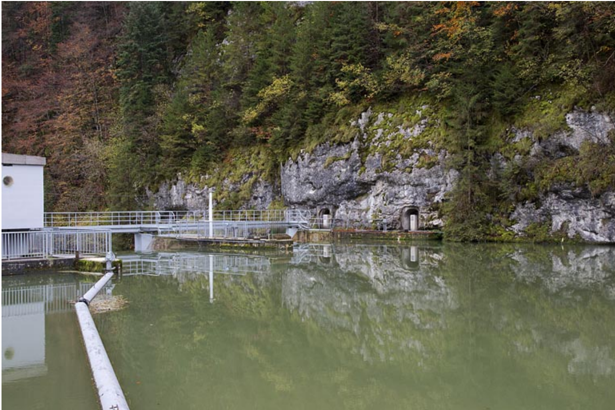
Barrage, vu d'amont (sud-ouest).
