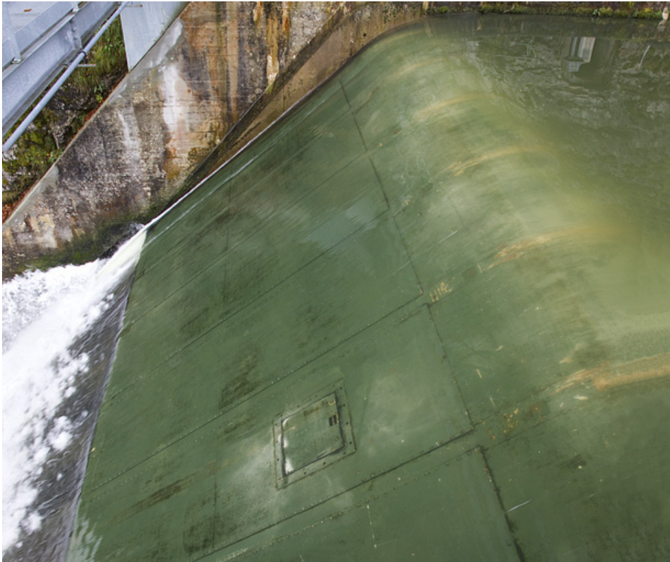
Barrage : une vanne toit.
