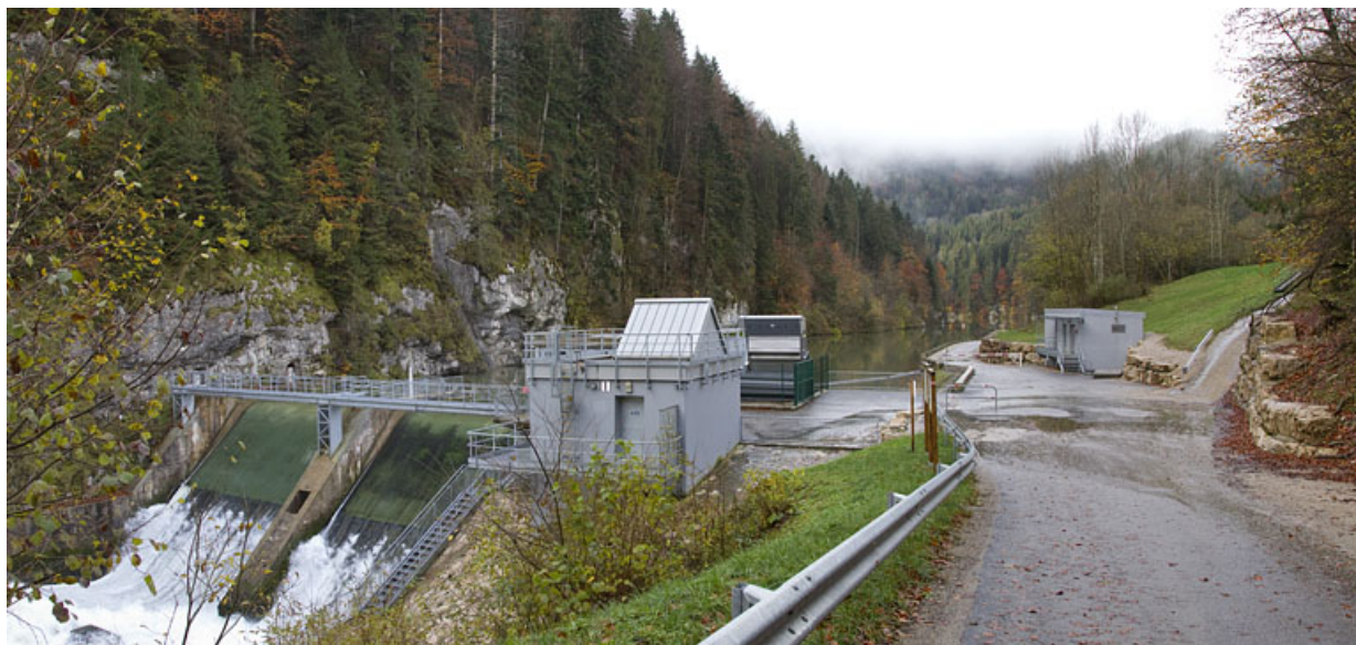
Vue d'ensemble depuis le nord-est (aval).
