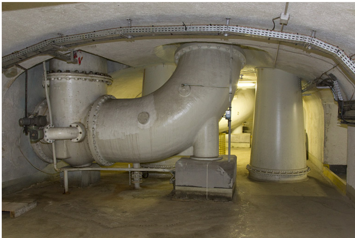
Centrale : soubassement, avec conduits d'alimentation des turbines et d'évacuation de l'eau.
