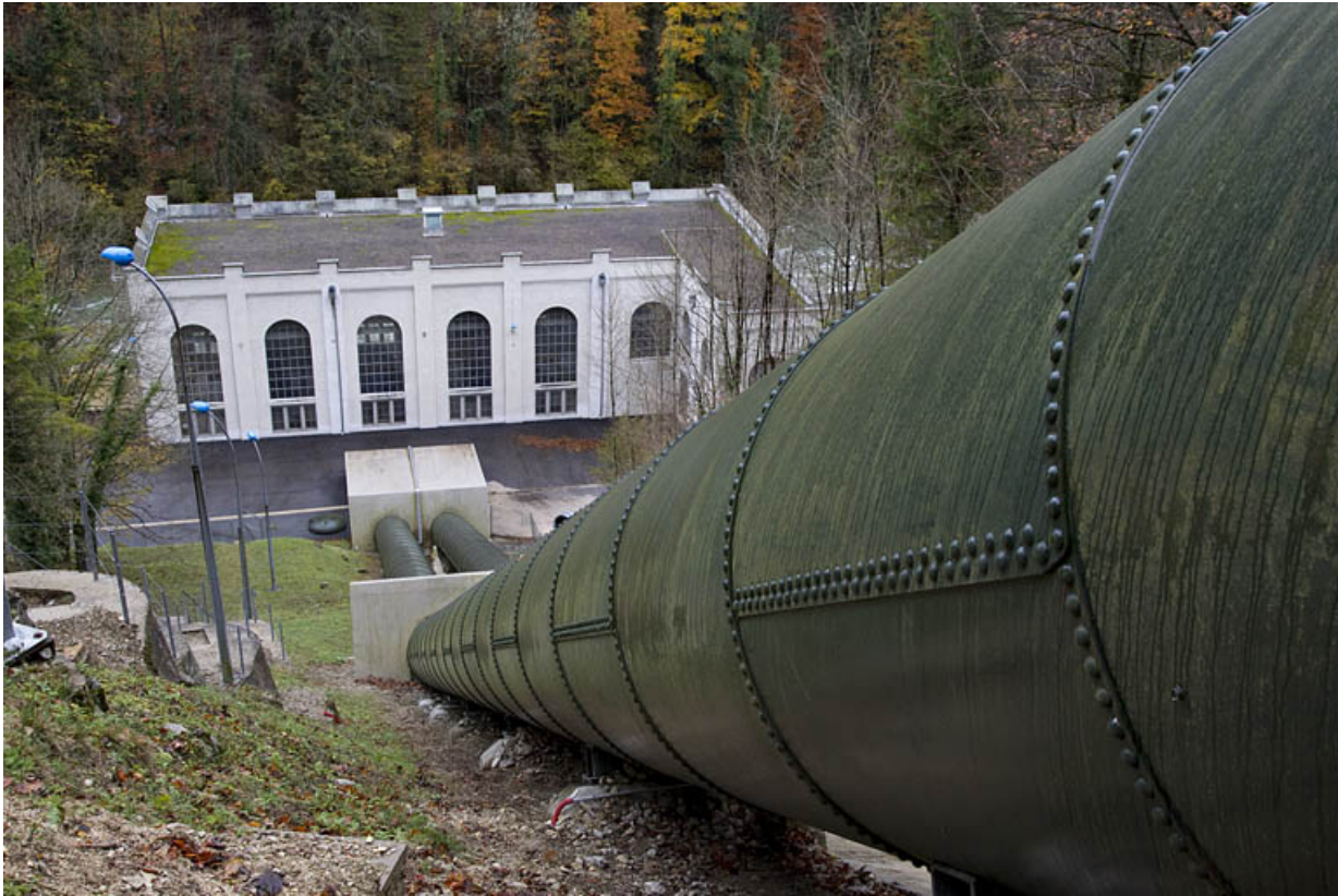
Conduite forcée : vue plongeante.
