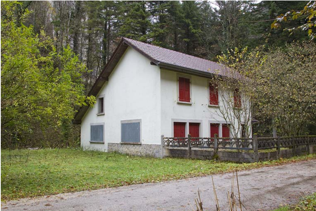
Ancienne école, vue de trois quarts gauche.
