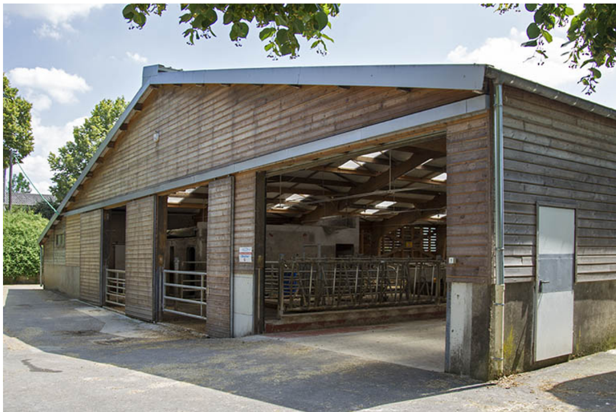
Pignon nord de l'étable ouest.
