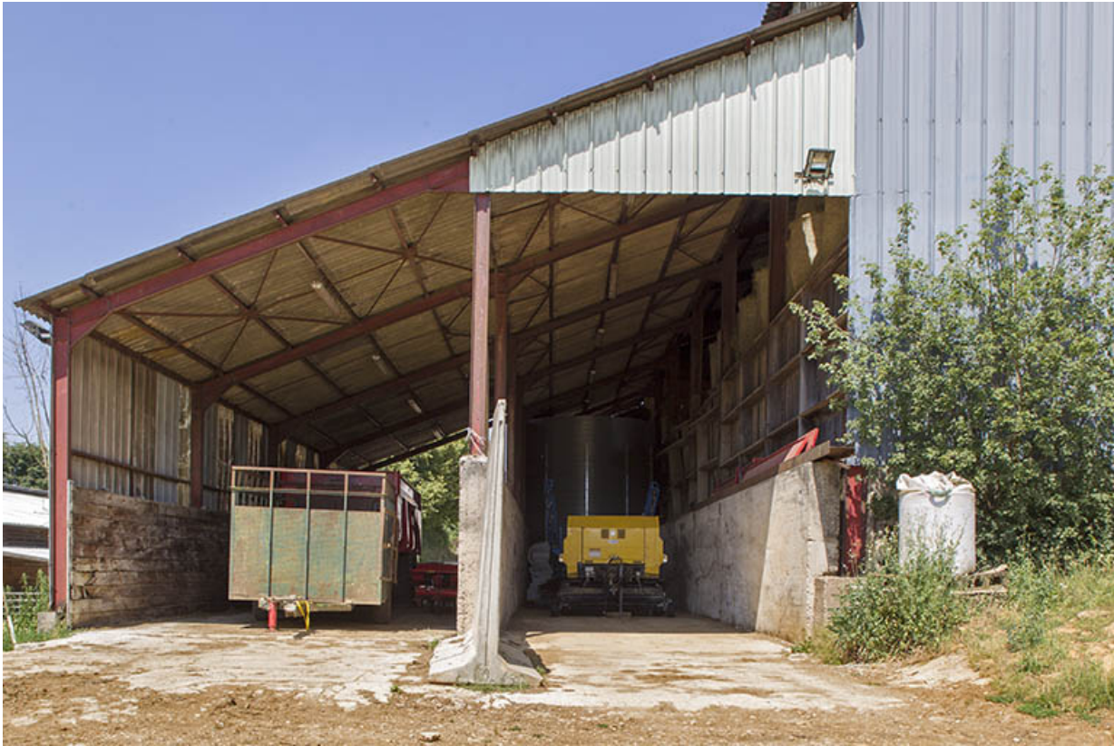
Appenti à l'ouest de l'entrepôt agricole.
