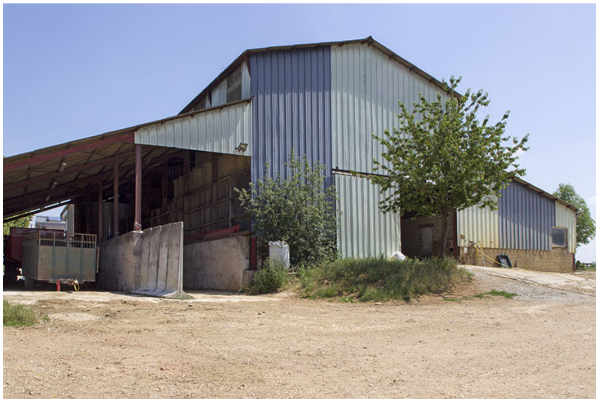
Pignon sud de l'entrepôt agricole.
