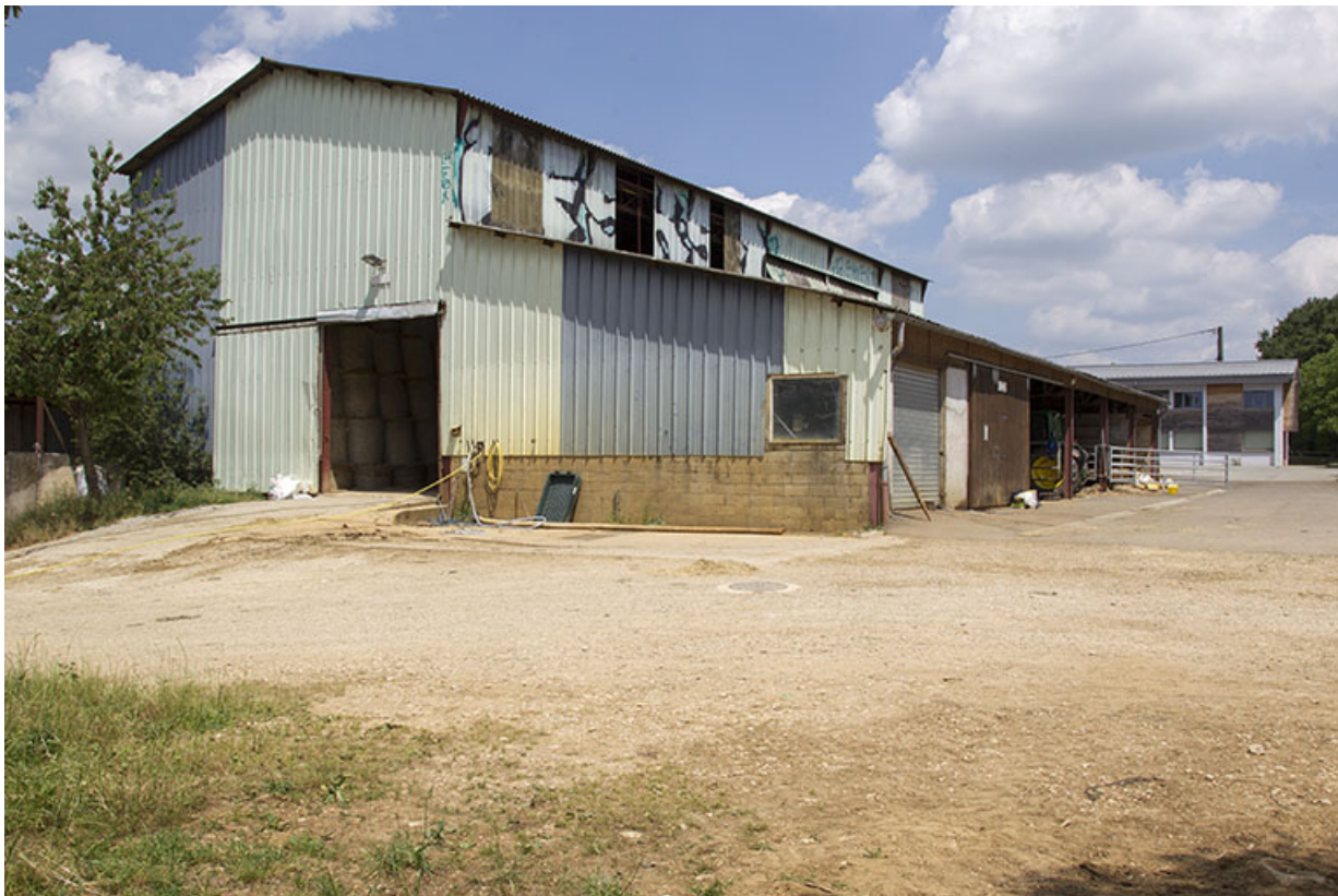
Vue de trois-quart sud-est de l'entrepôt agricole.
