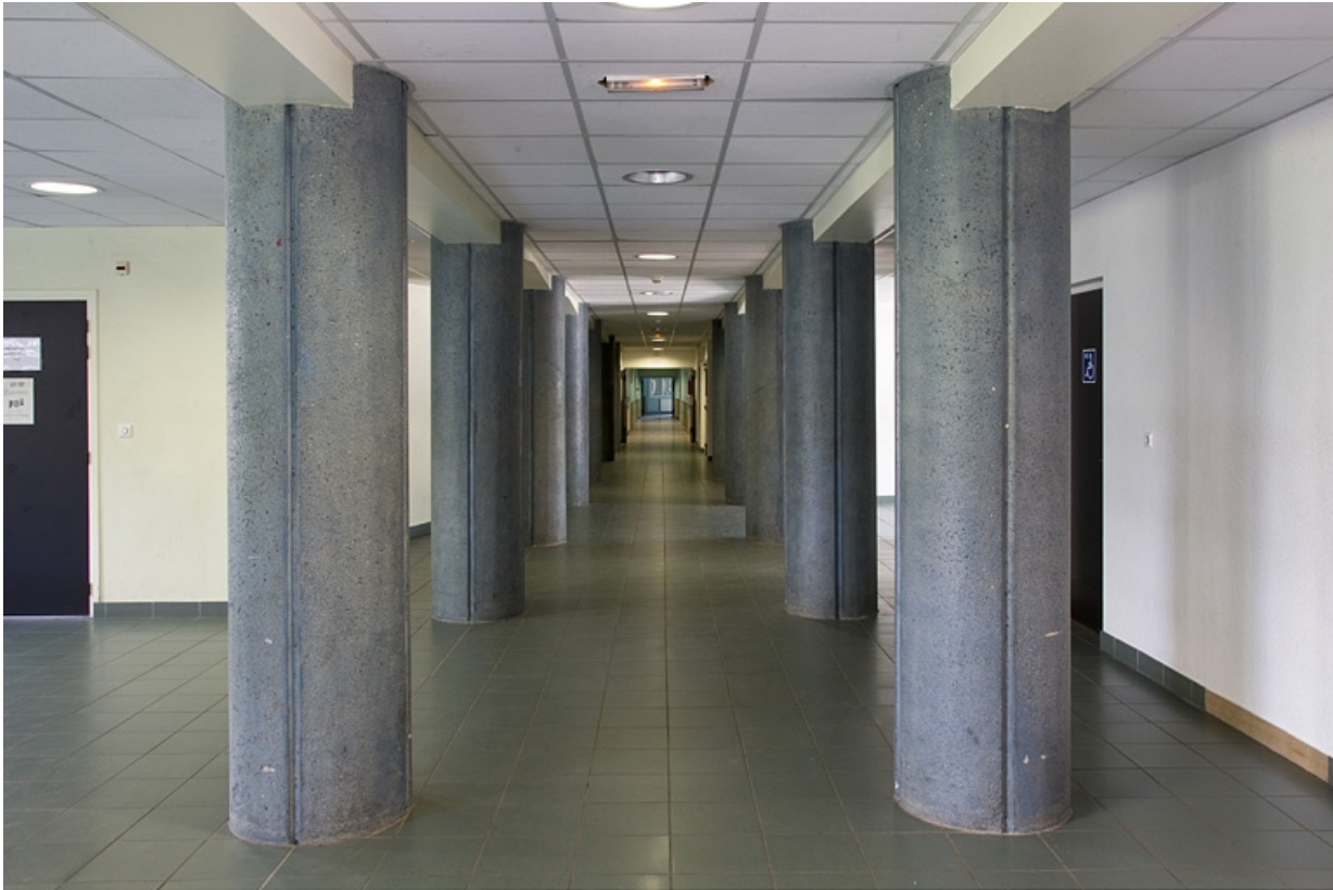
Bâtiment de l'infirmerie : colonnes.
