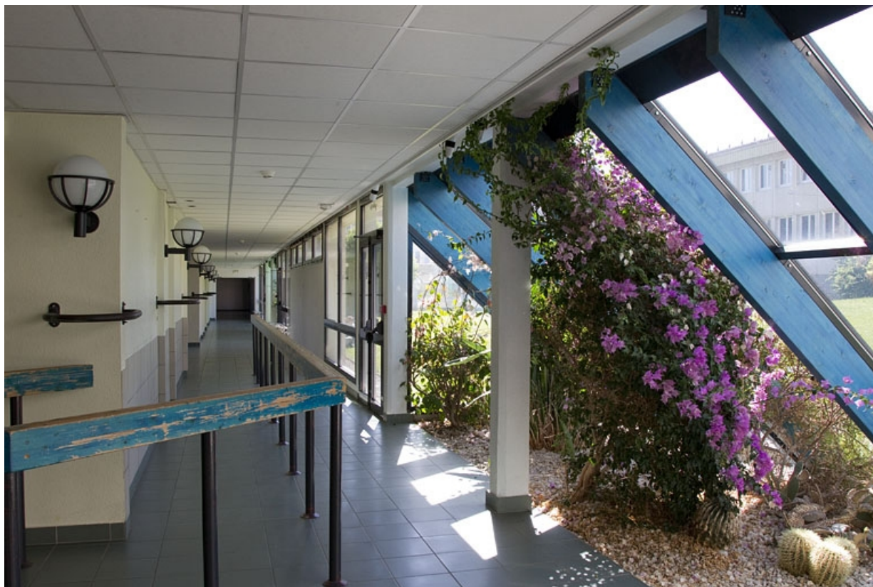
Restauration : couloir côté sud.
