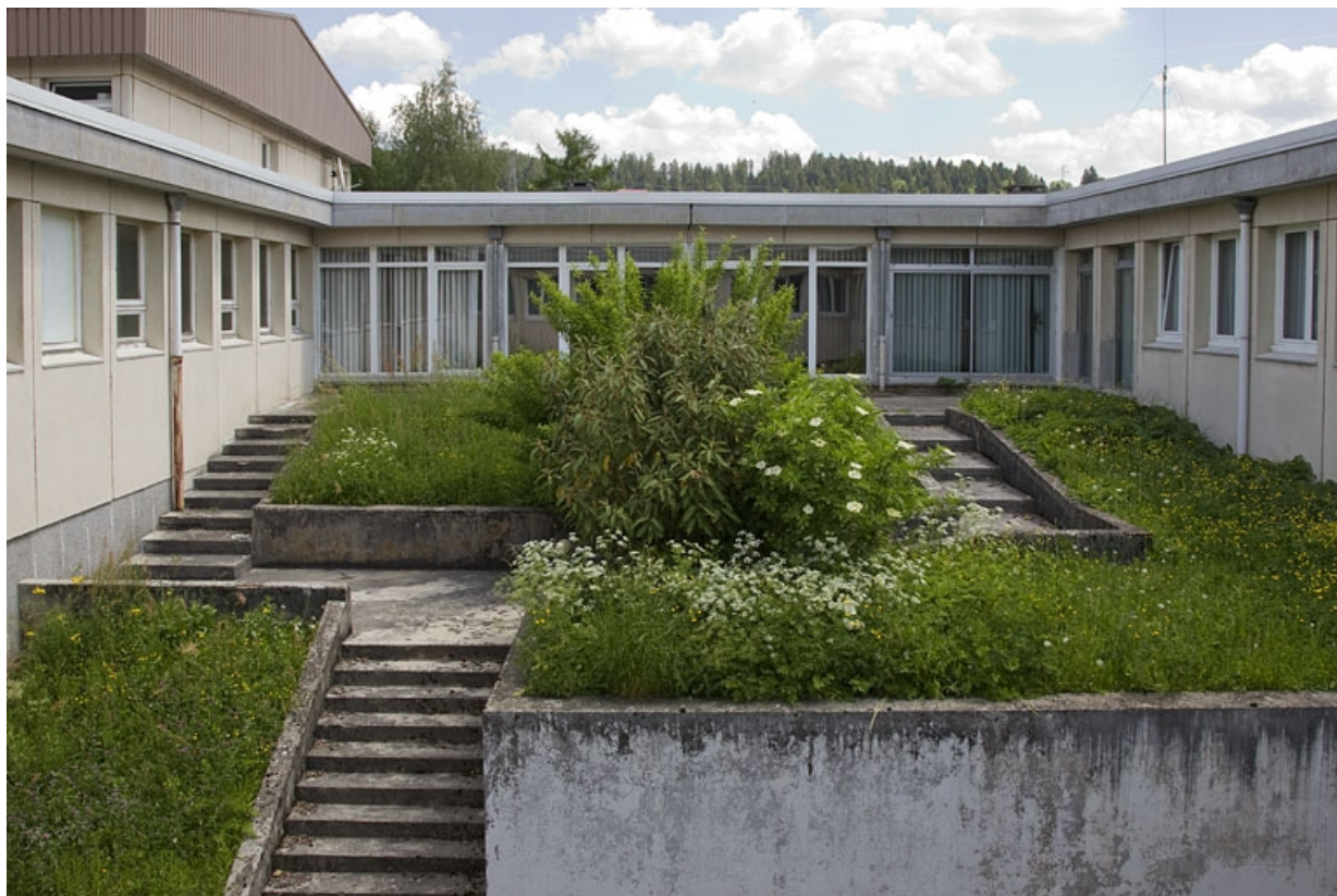
Bâtiment de l'administration : patio.
