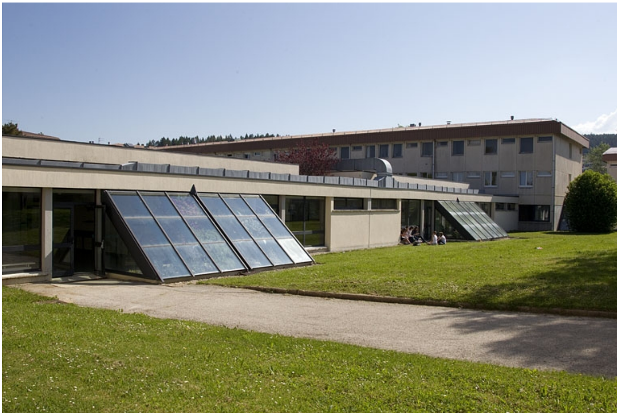
Bâtiment de la restauration : face sud.
