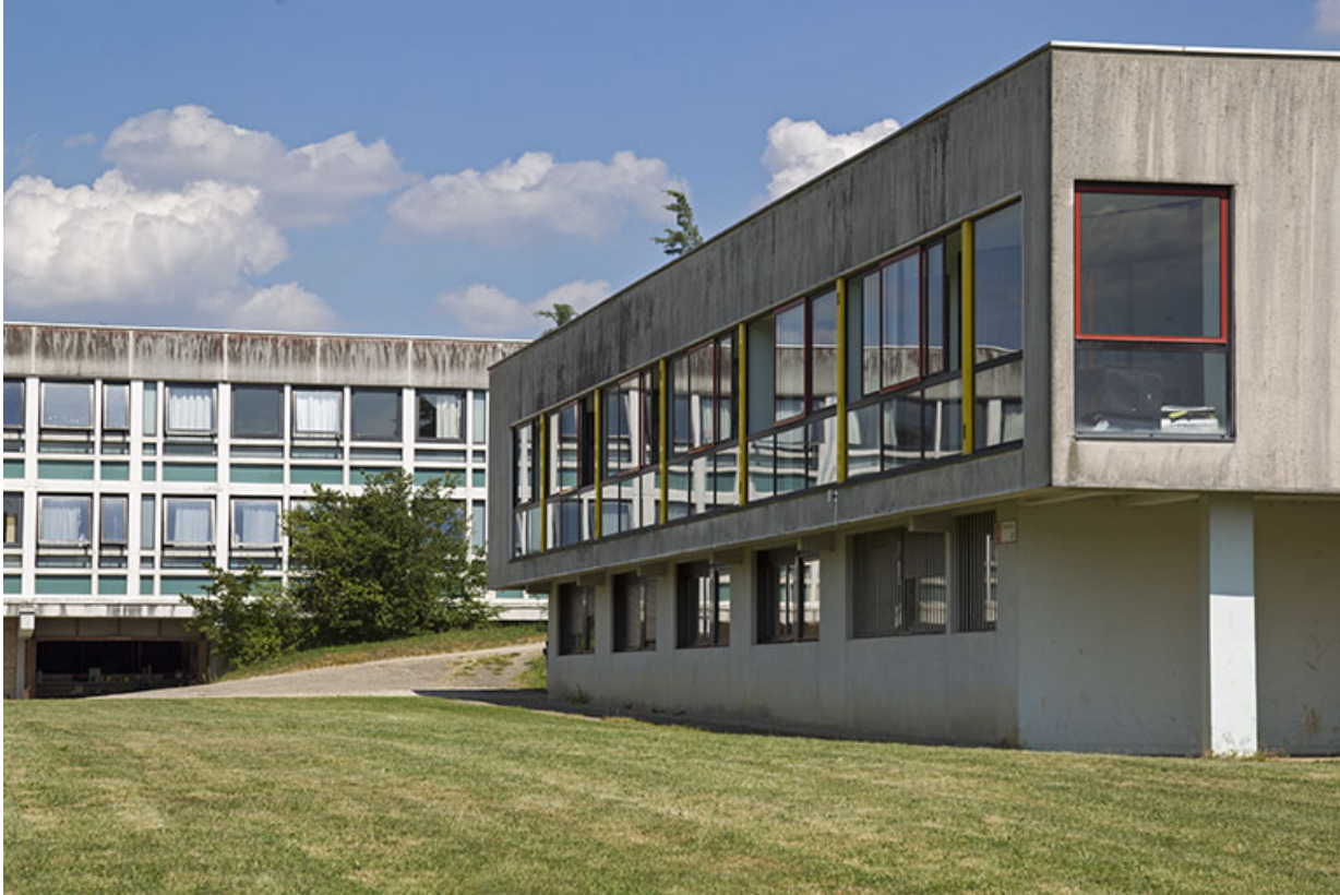
Angle nord-ouest du bâtiment d'internat de filles.
