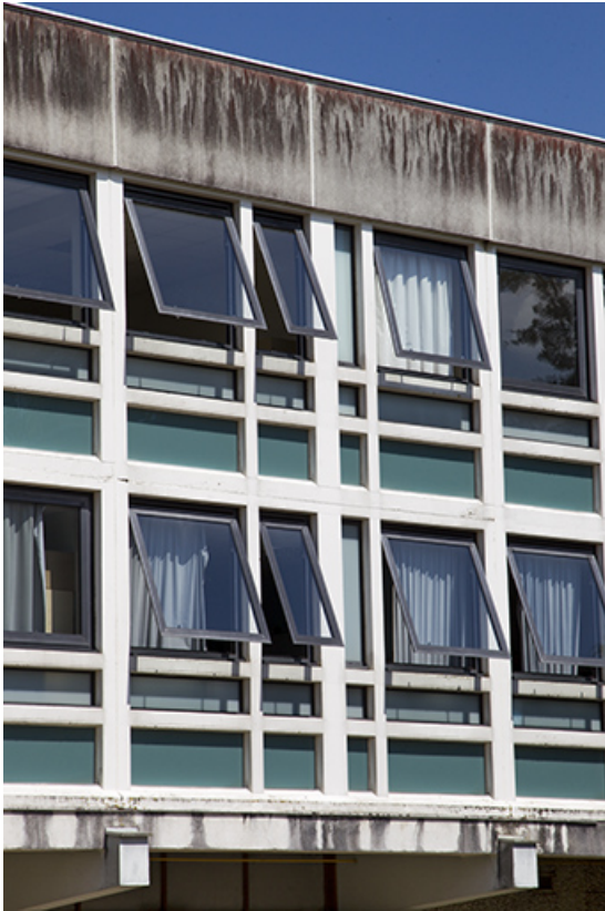
Détail de façade postérieure - ouest - de l'externat.
