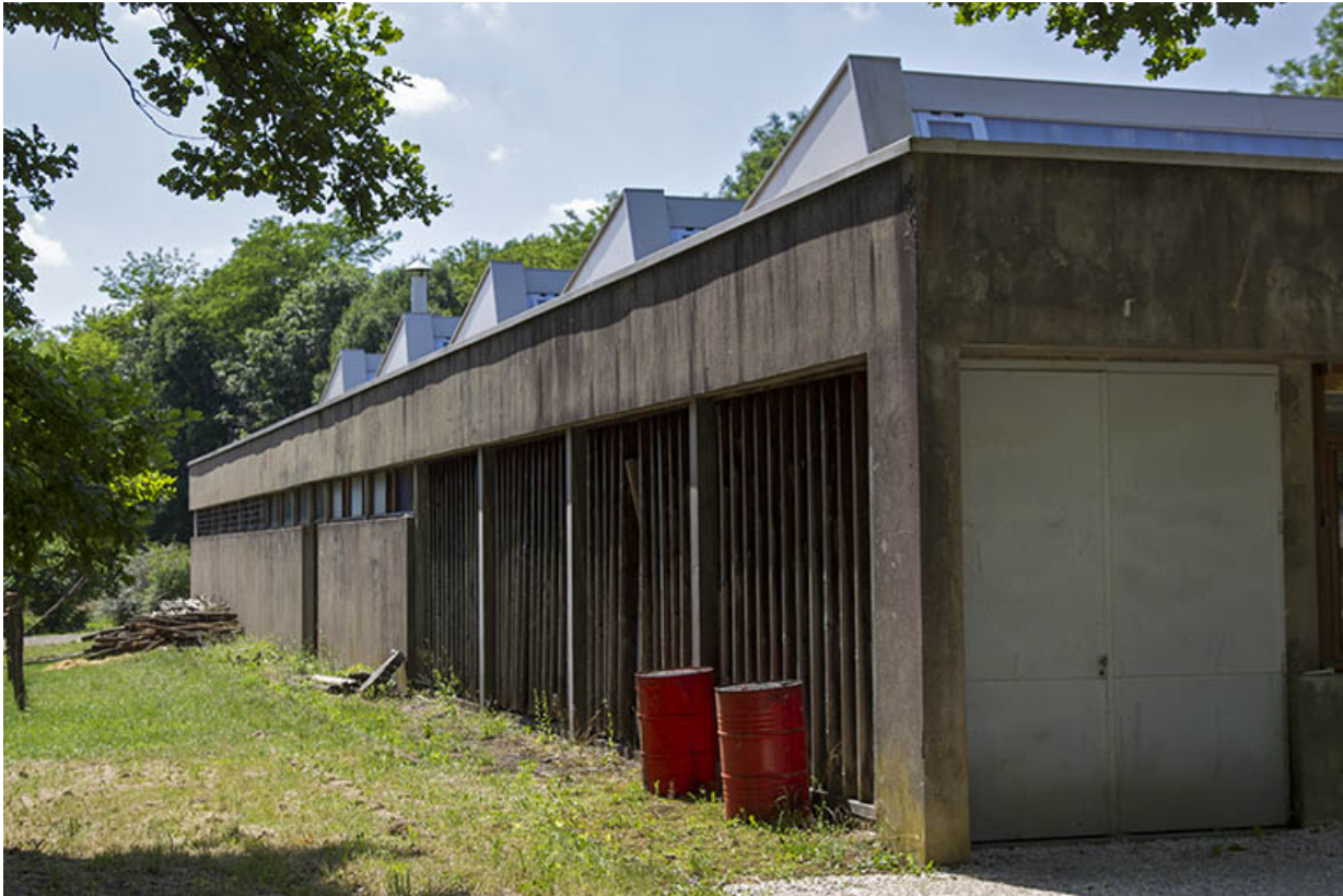
Angle sud-est de l'atelier.
