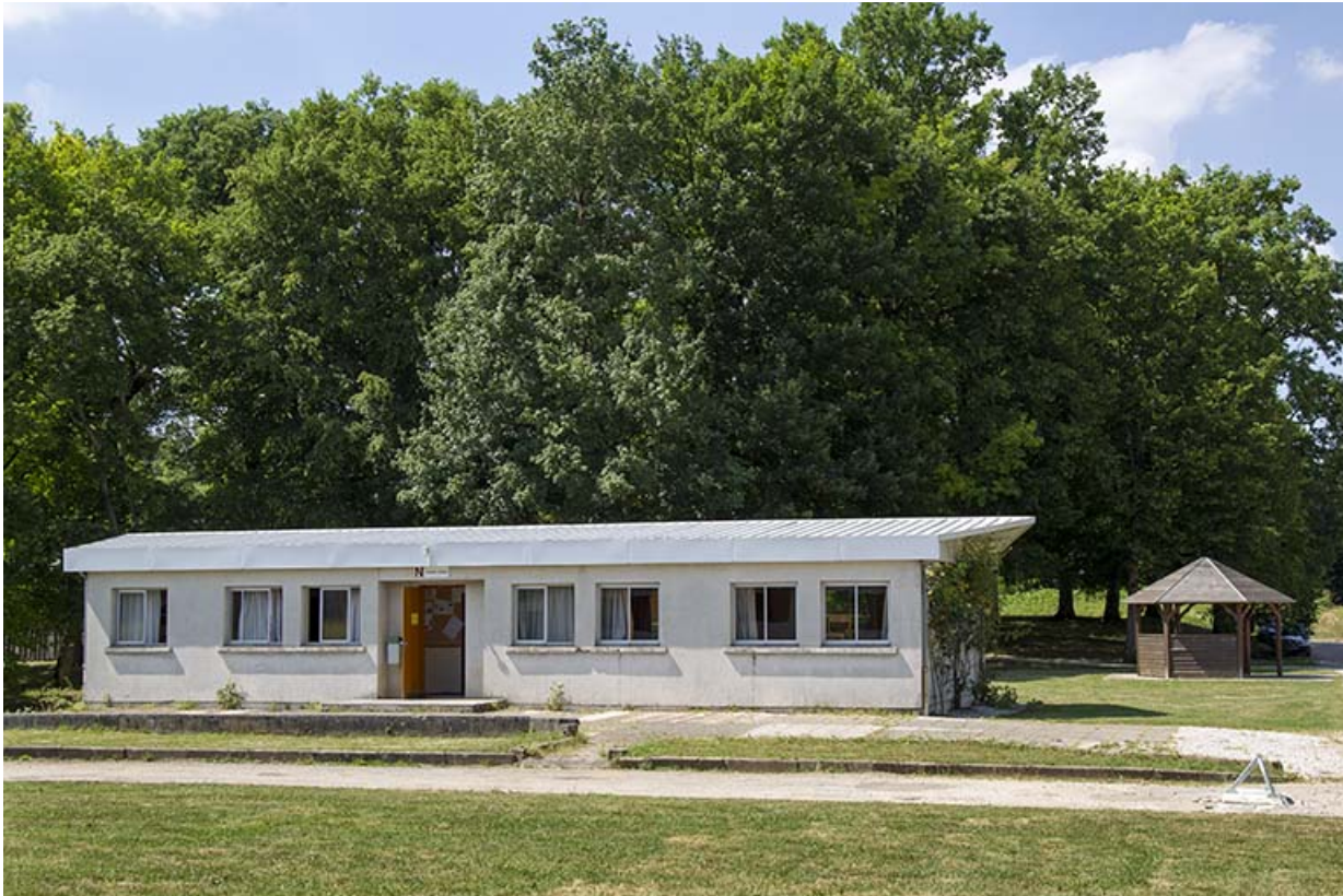
Façade sud des salles des classes préparatoires.
