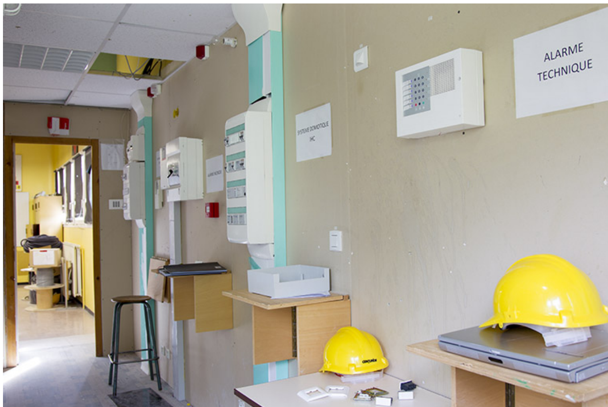
Intérieur de l'atelier des formations en électrotechnique.
