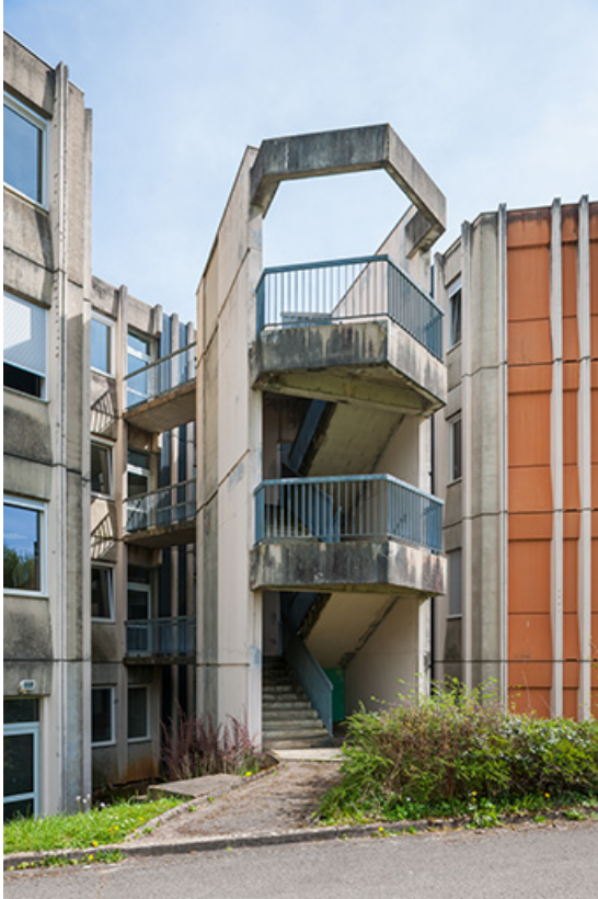
Détail de l'escalier extérieur de l'internat.
