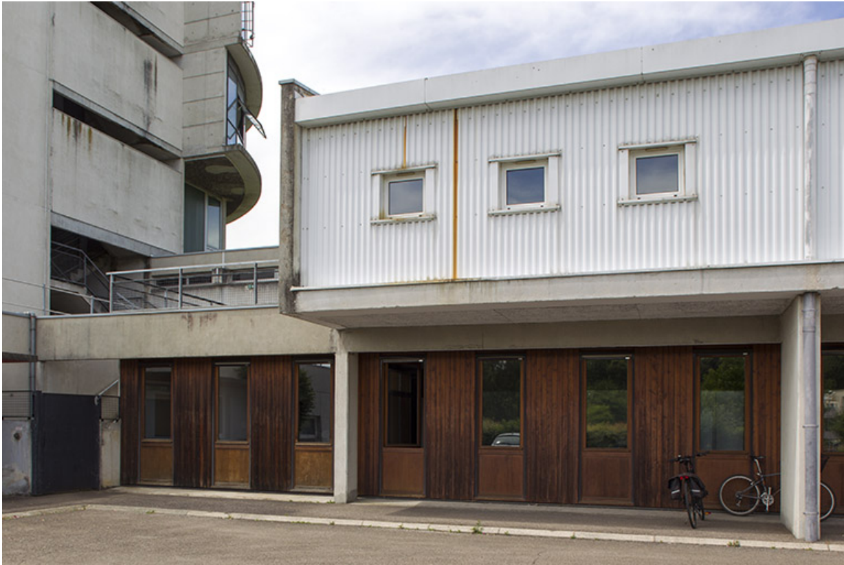
Entrée au rez-de-chaussée du bâtiment "agencement".
