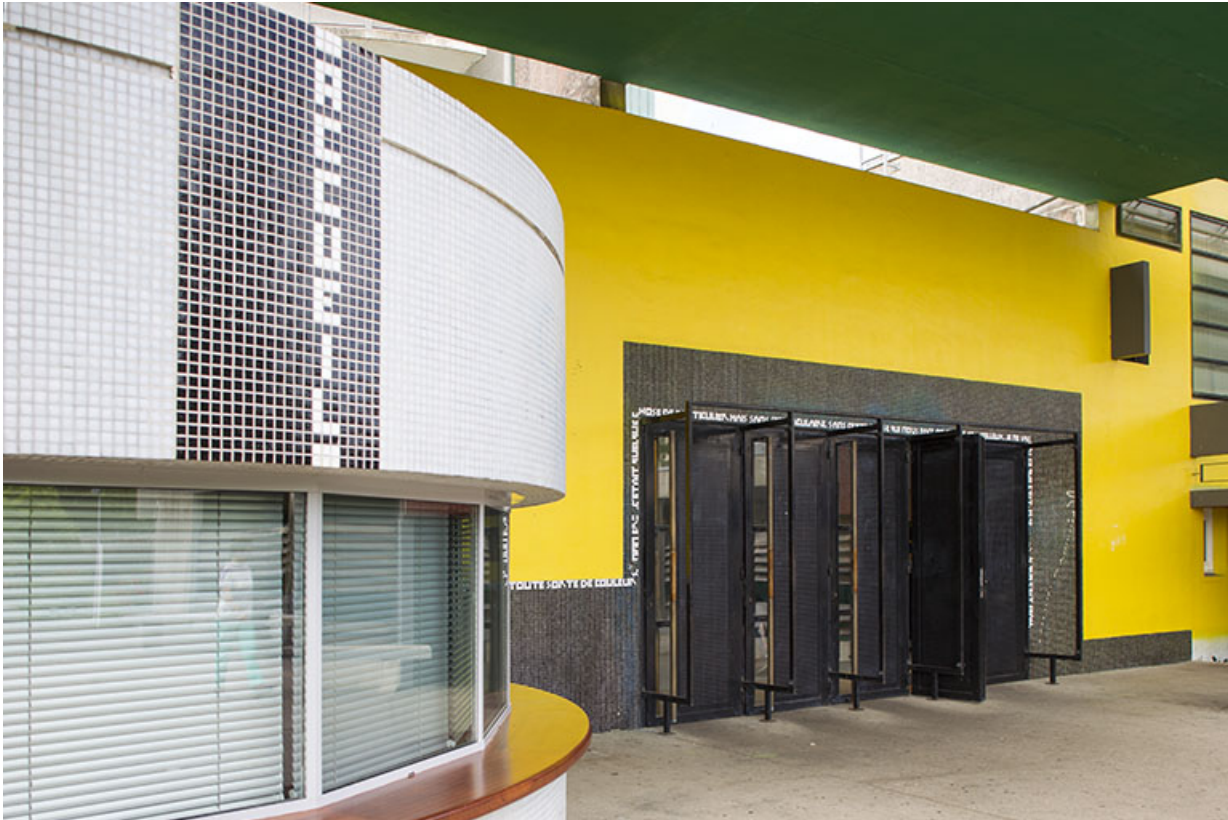
Détail de l'entrée vue de trois-quart sud.
