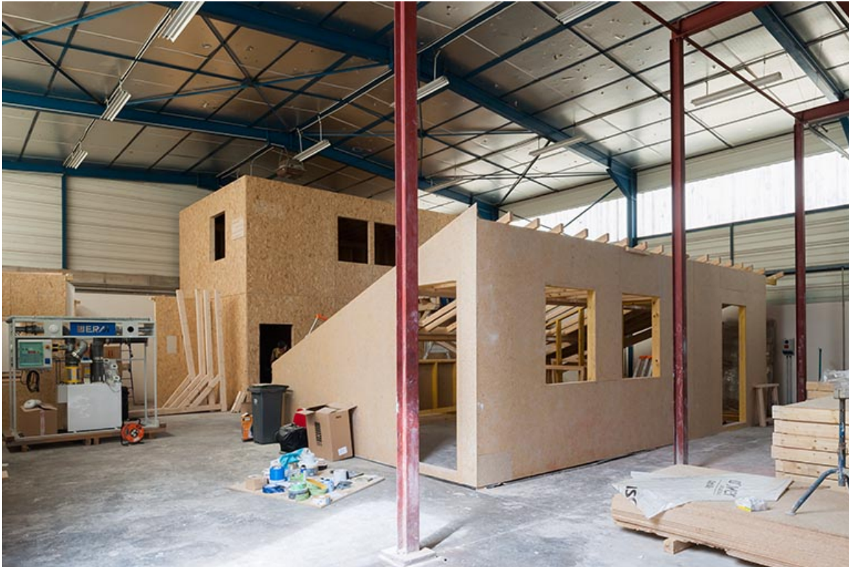
Espaces d'apprentissage des techniques de menuiserie.
