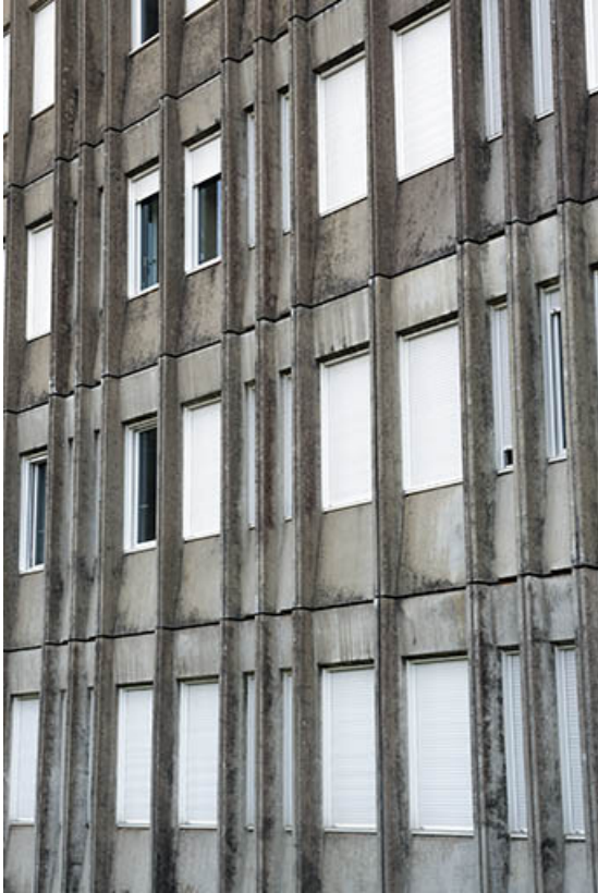
Détail de la façade de l'internat.
