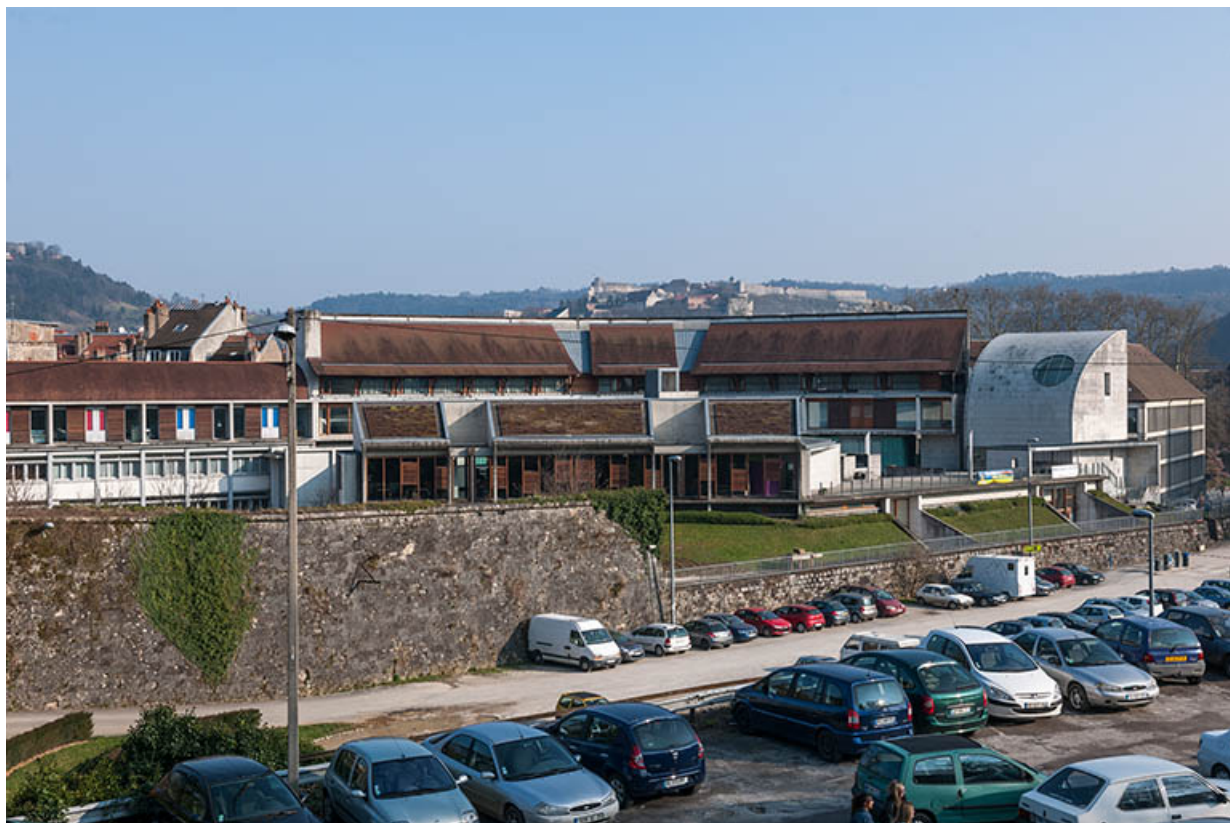
Vue d'ensemble des parties sud depuis l'ouest.
