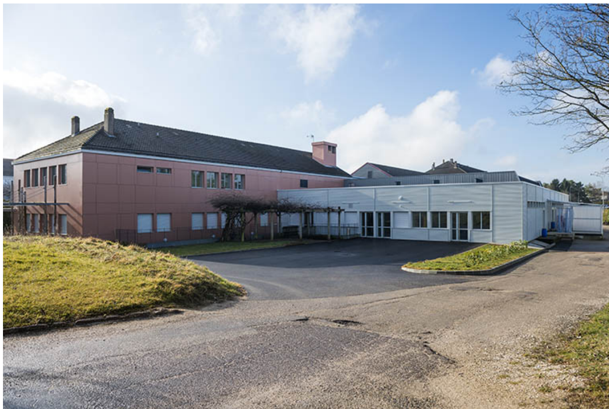
Vue de trois-quart des services communs.
