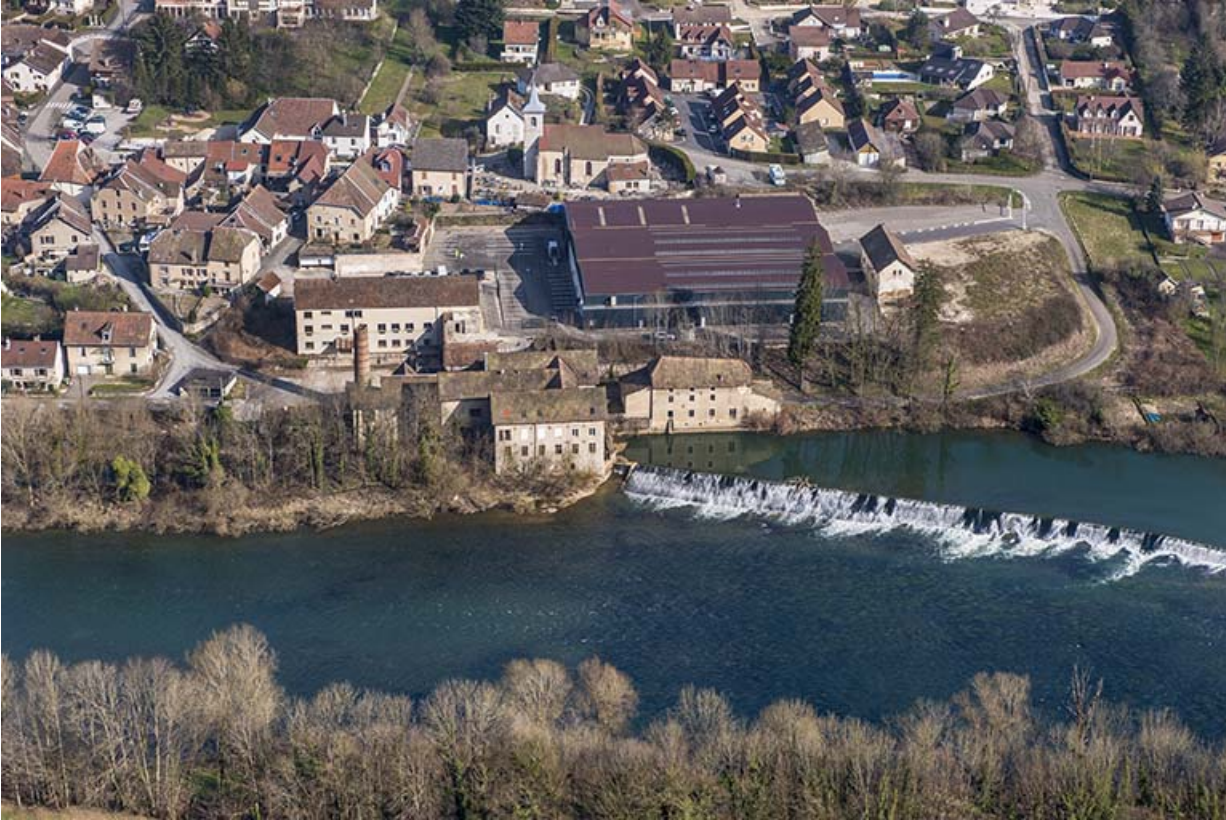
Vue d'ensemble plongeante depuis le sud.
