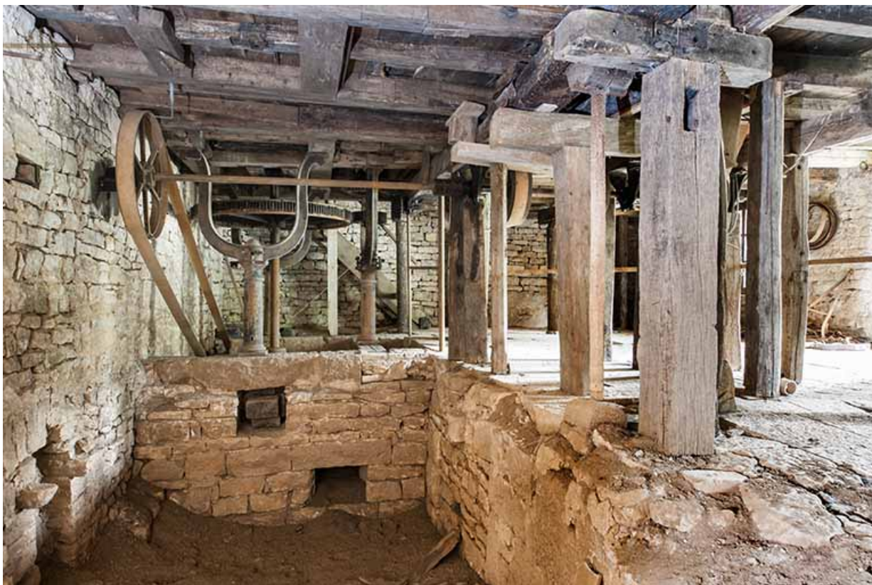
Etage de soubassement. Vue depuis l'ouest.
