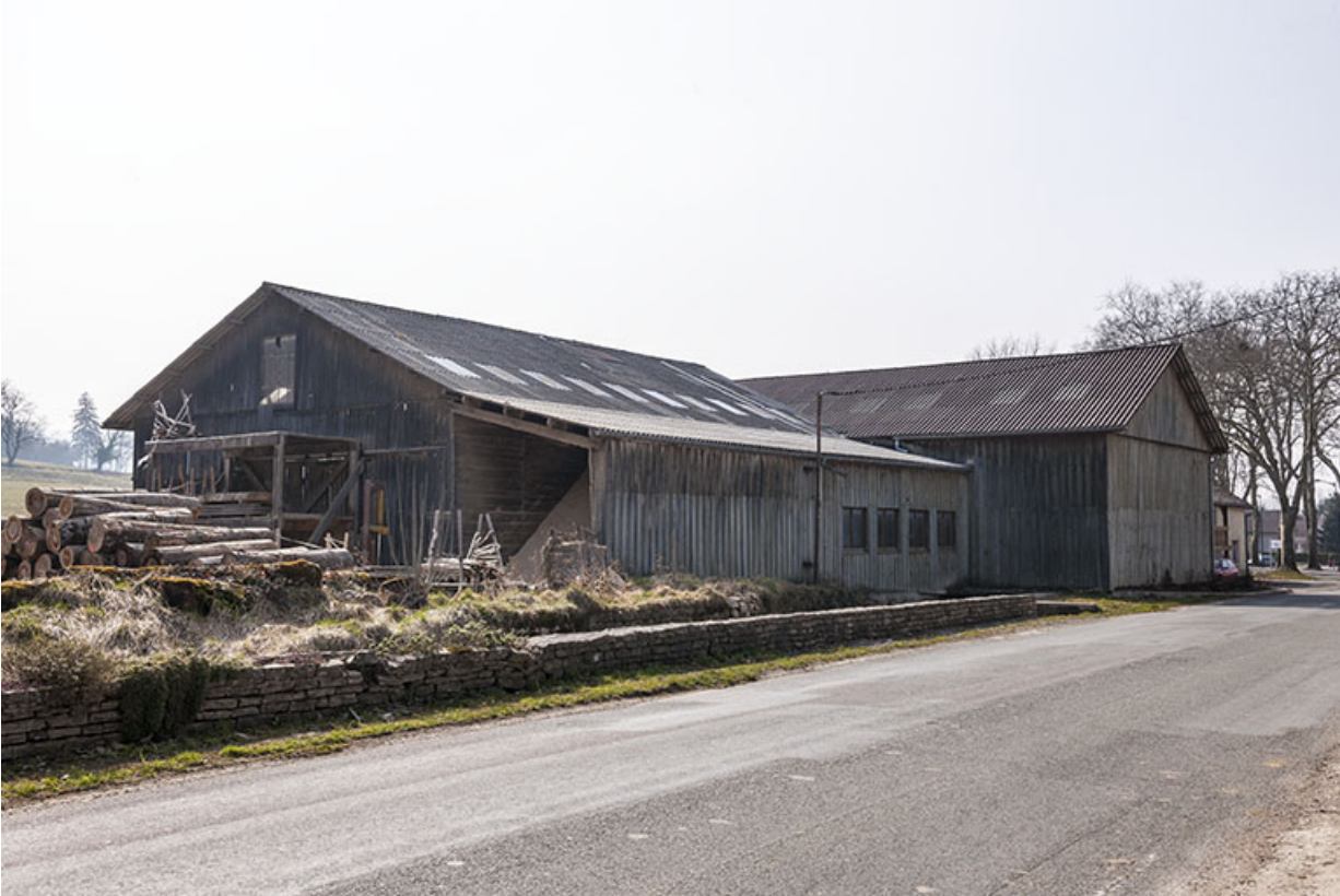
Atelier de sciage depuis le nord-est.
