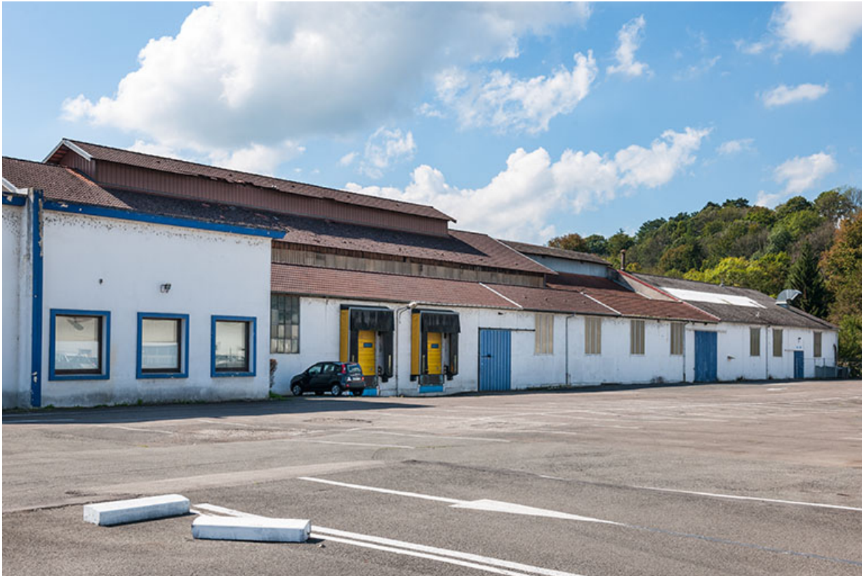
Façade nord vue de trois quarts.
