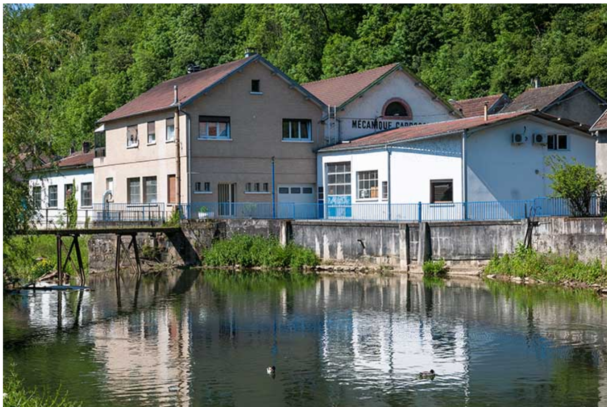
Vue du pont, depuis l'amont.
