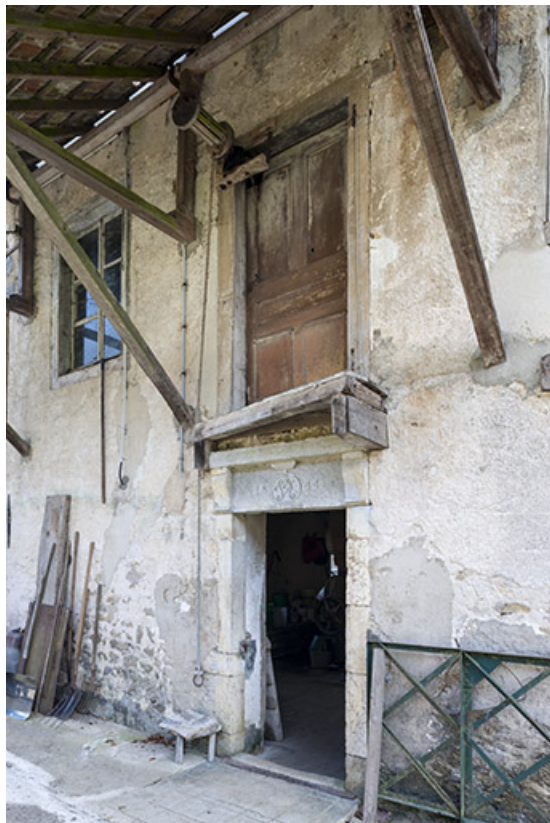
Mur-pignon ouest vu de trois quarts.
