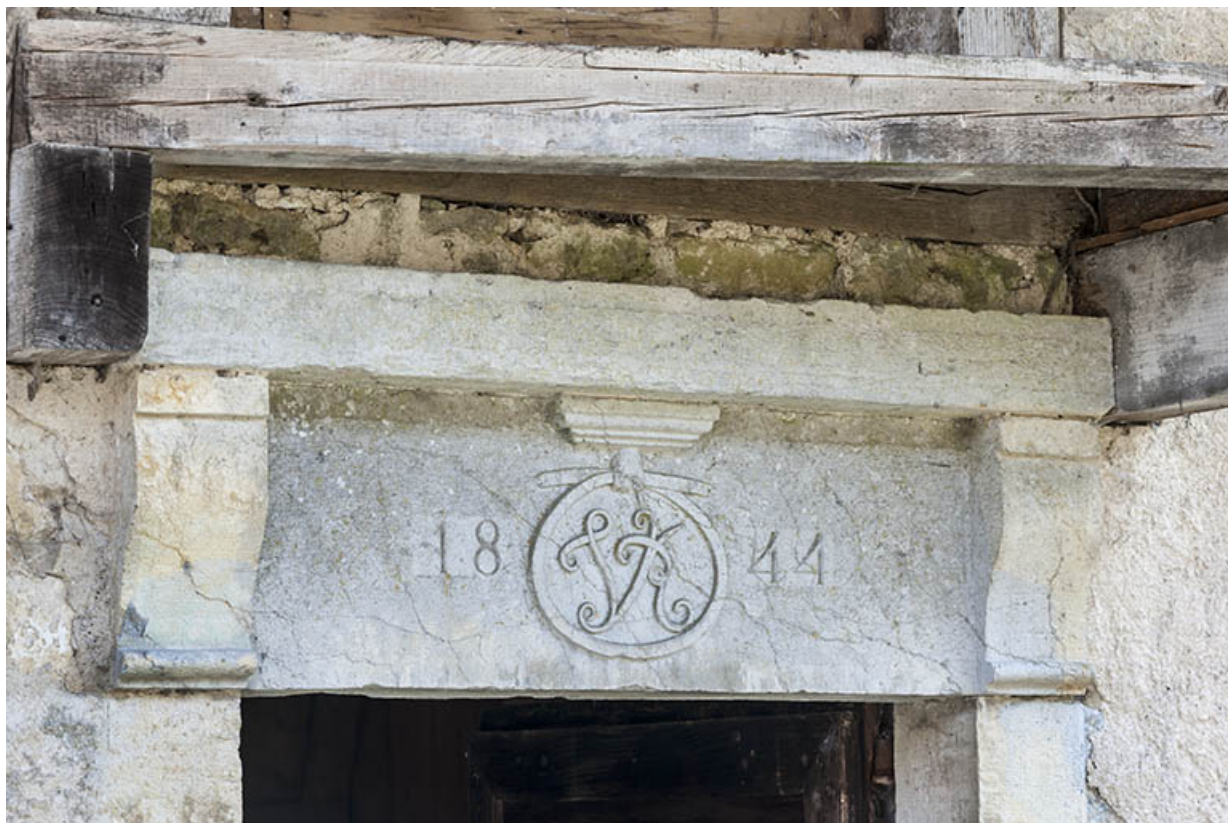
Mur-pignon ouest. Détail du linteau.
