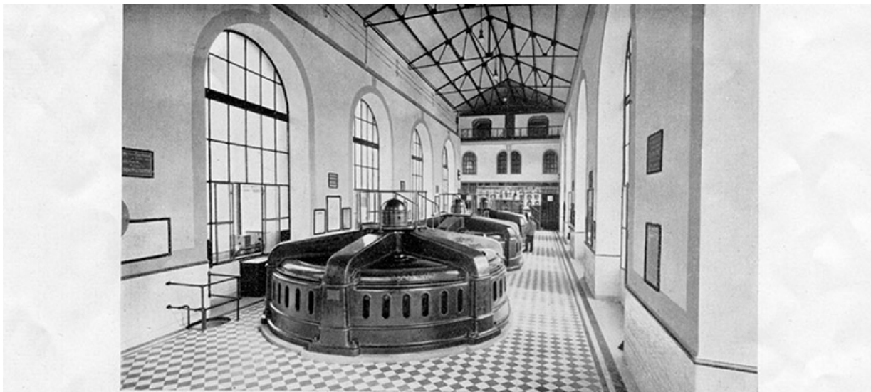
USINE DU CHATELOT : Salle des machines comprenant 3 groupes turbines et alternateurs de 1.000 CV chacun et 1 condensateur synchrone de 625 KVA.
