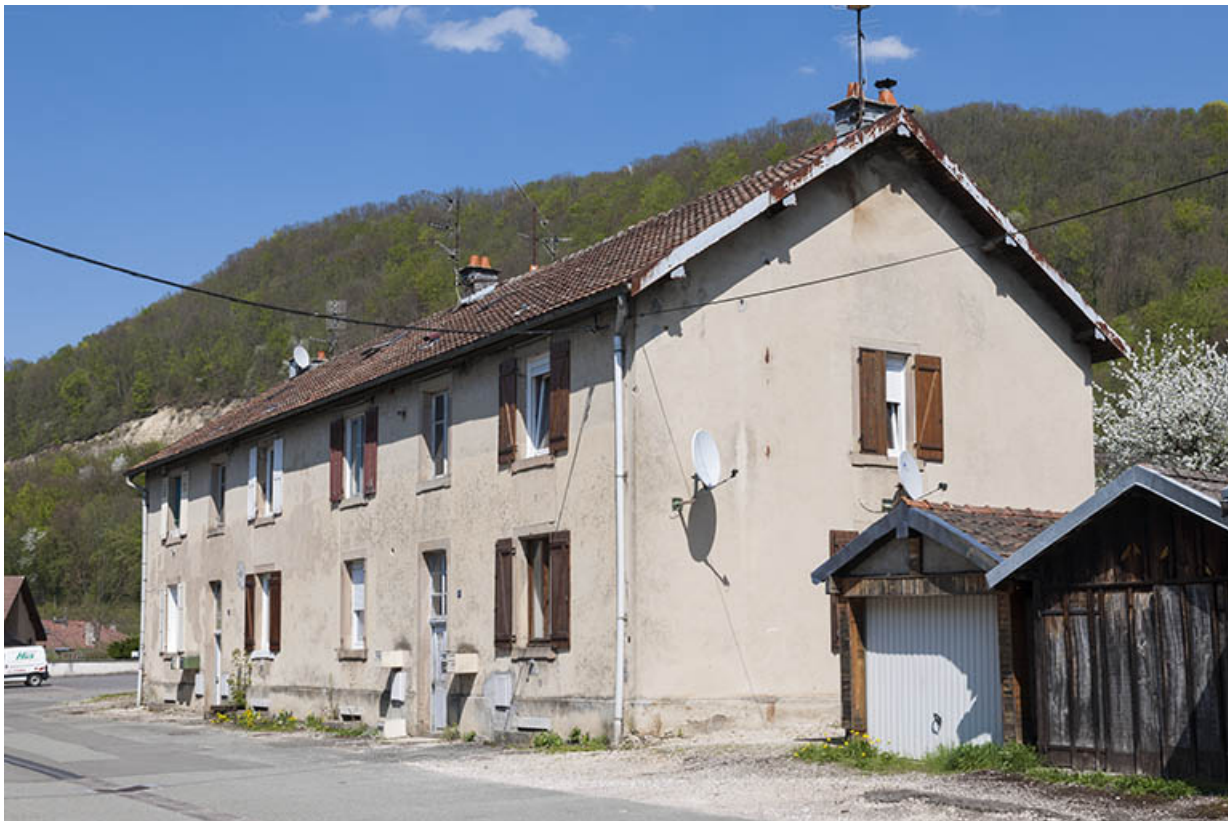
Habitation (6-8 logements) vue de trois quarts.
