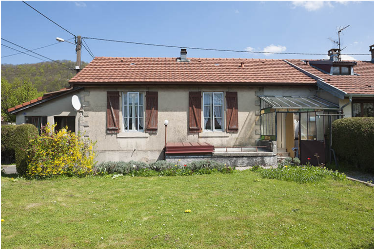
Façade postérieure d'une maison individuelle.
