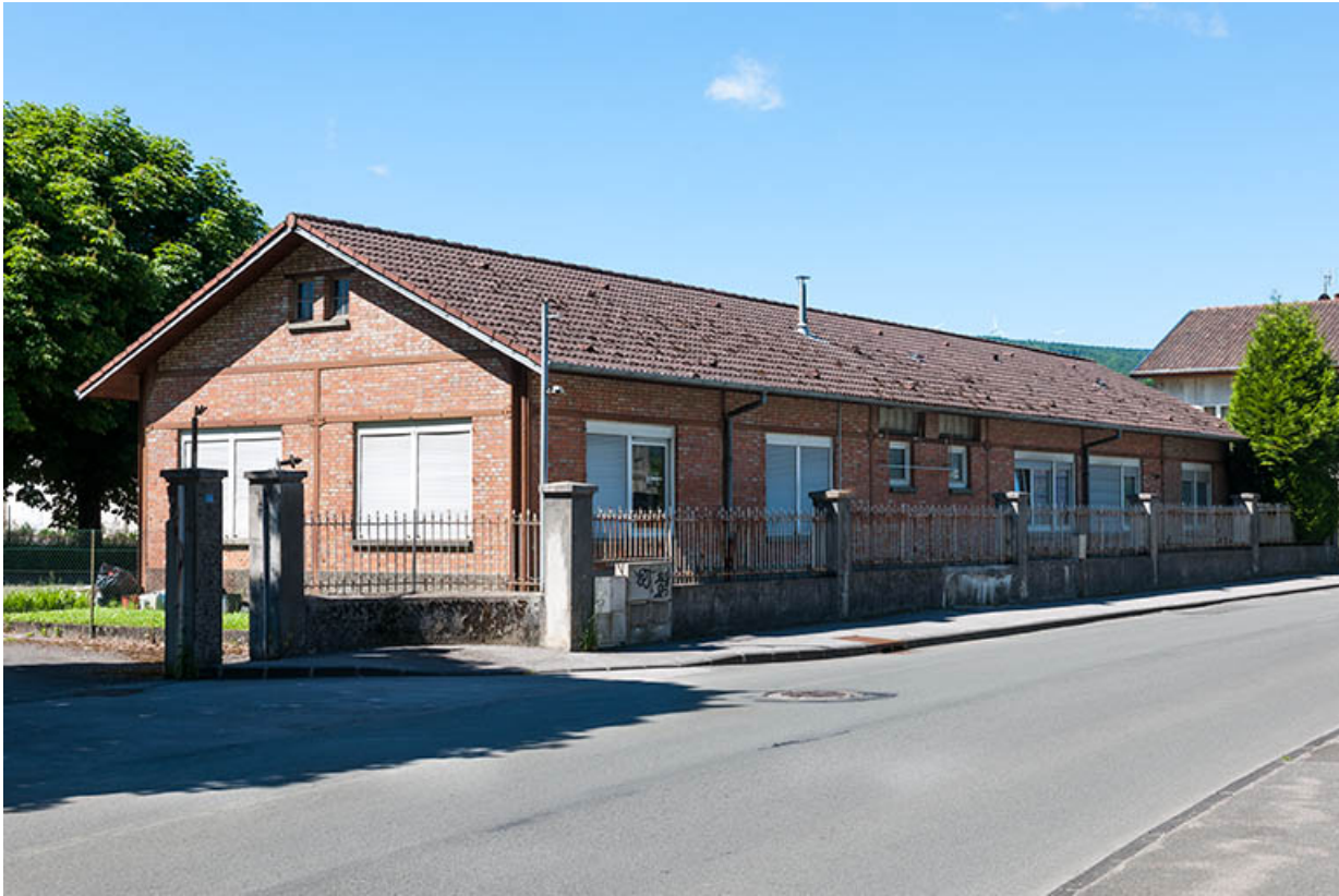
Bâtiment des logements et bureau.
