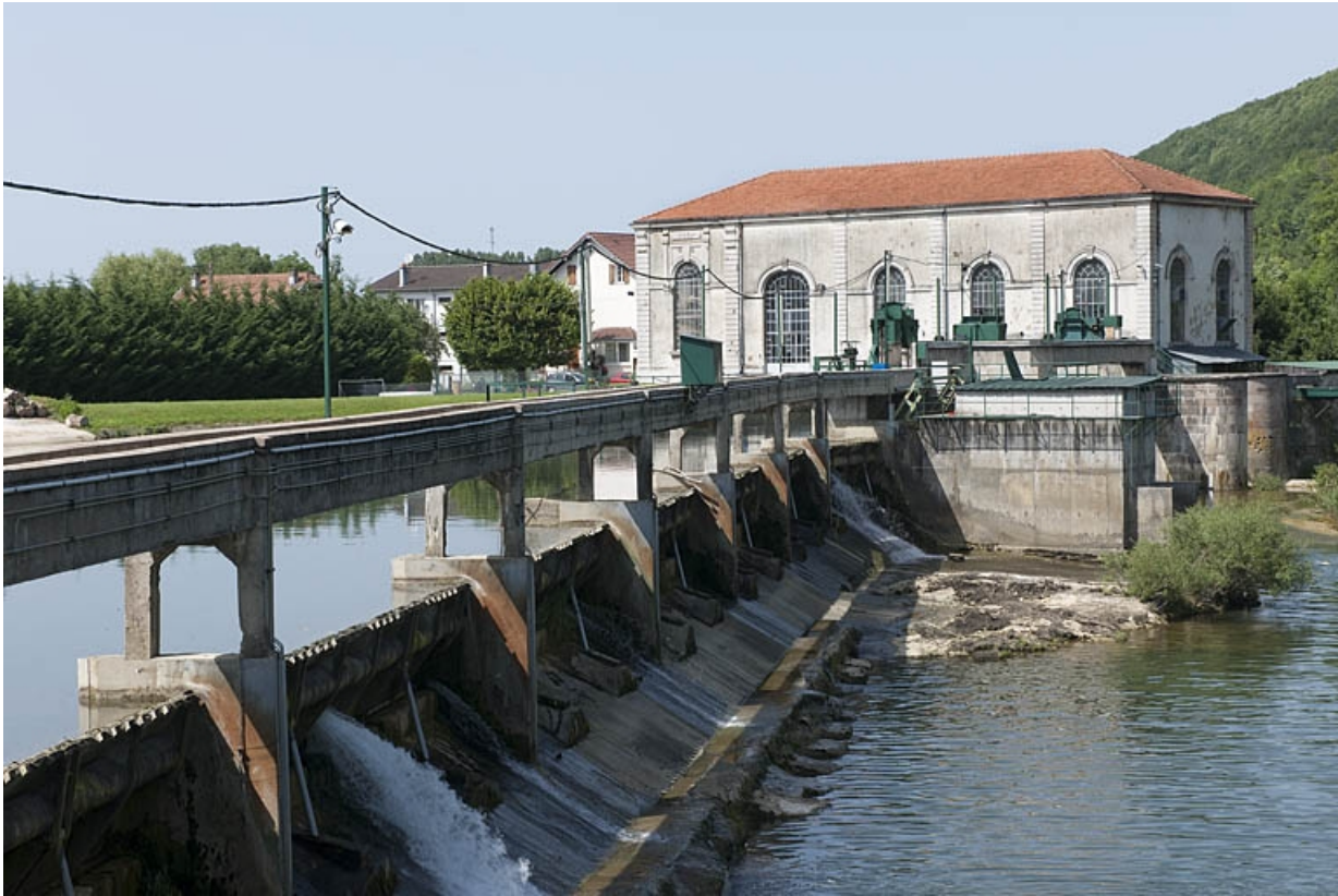
Les déversoirs du barrage et la centrale.
