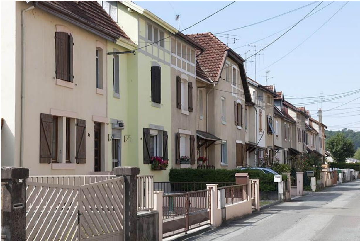
Rue de Somme. Façades nord.
