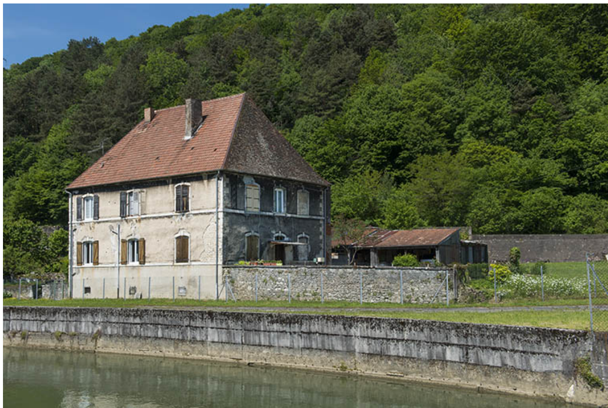
Bief d'amenée et logement patronal.
