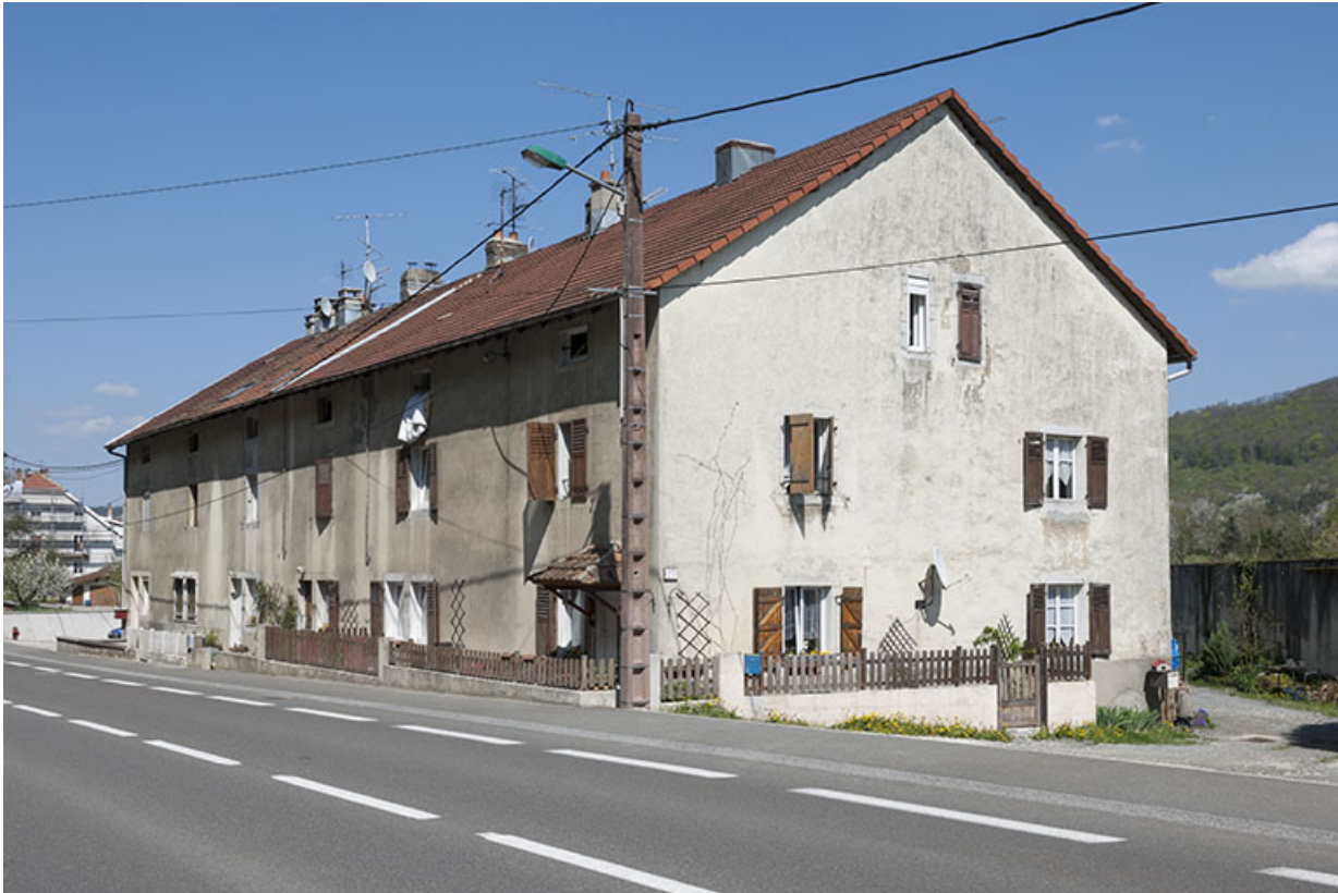
Logement d'ouvriers vu de trois quarts droite.
