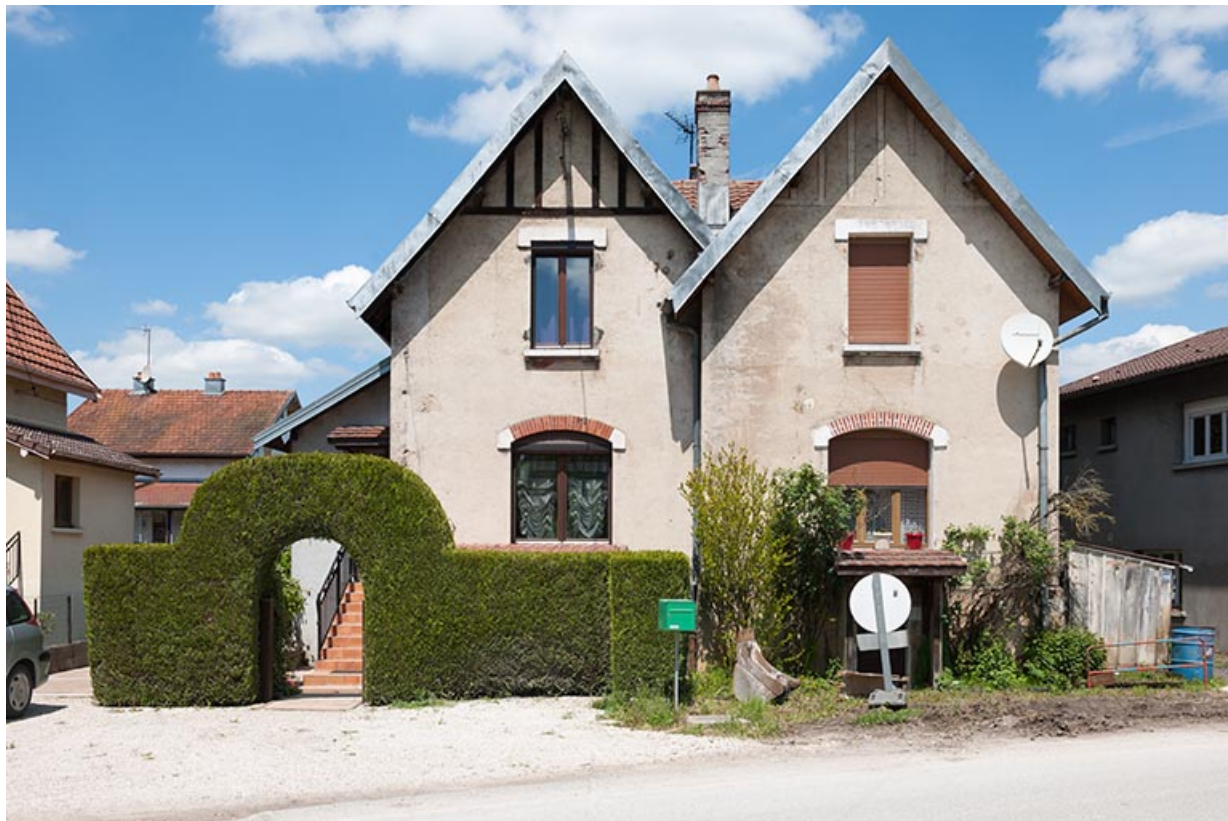
Façade antérieure d'une maison jumelée.
