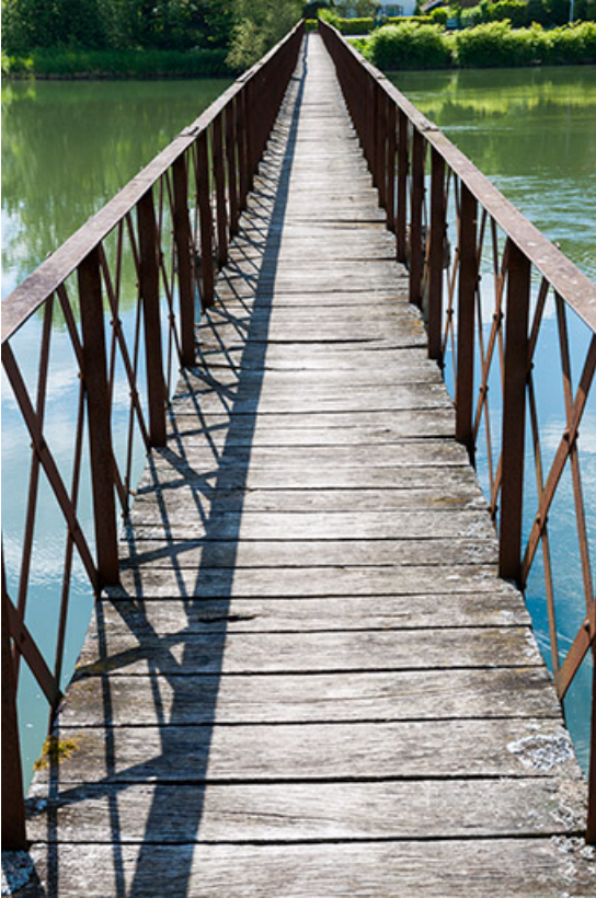
La passerelle. Vue rapprochée.
