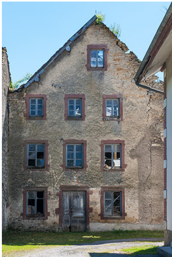
Pignon nord du moulin.
