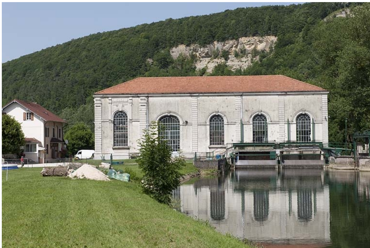
Façade sud de la centrale.
