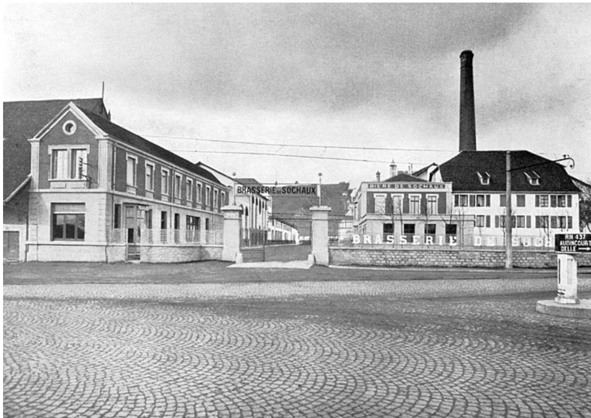
Vue d'ensemble de l'entrée.
