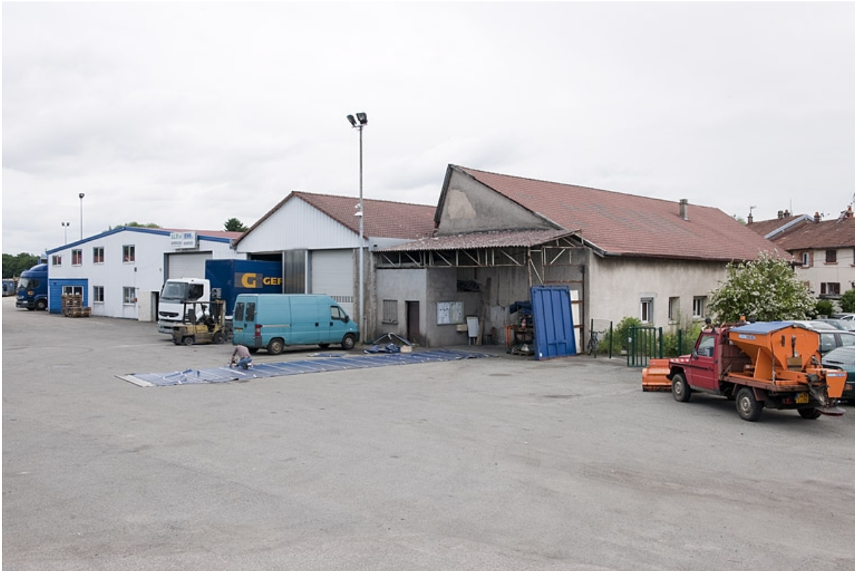
Vestiges d'un bâtiment industriel (à droite).
