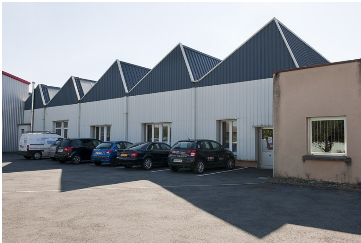
Bardage de la façade nord.
