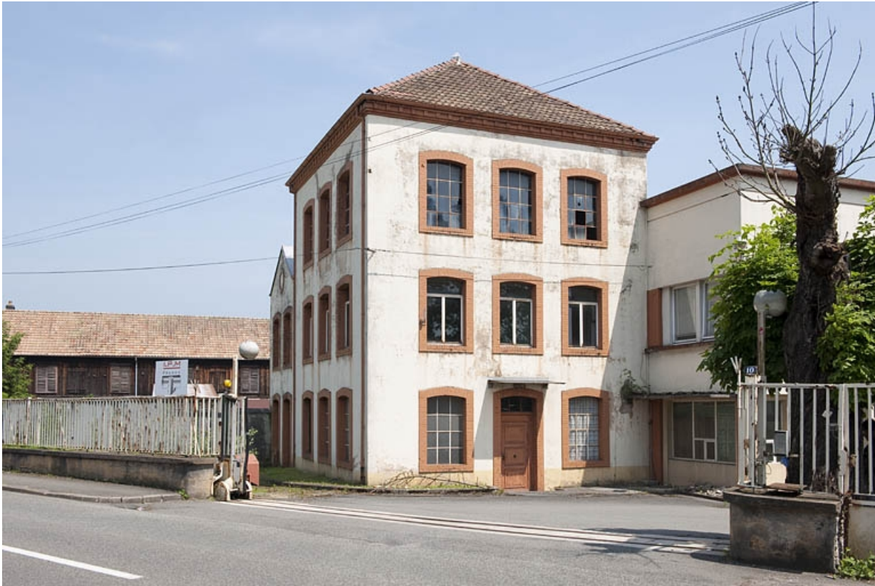
Bâtiment d'entrée vu de trois quarts.
